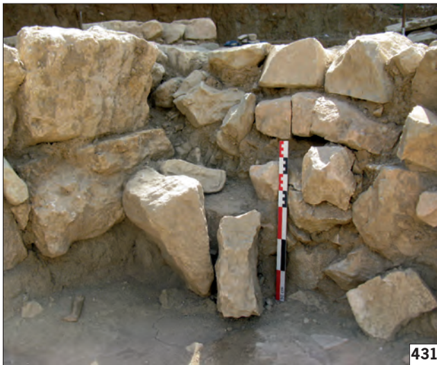
Fig. 431 _ Le calage du poteau d'échafaudage à l'angle de la cloison MR2010 (à gauche) et de la façade MR2016 (à droite) dans la pièce 4 du bâtiment oriental.
