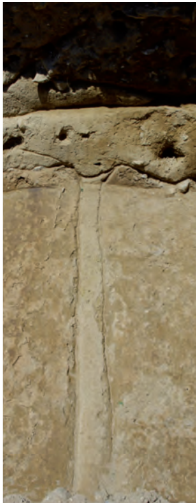
Fig. 12 : détail de l'ornière US 1154 de la chaussée VO1043. Cl. O. Maufras/Inrap. [Photo n° 557].
