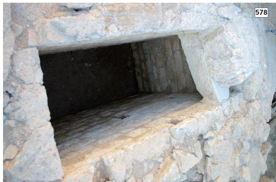
Fig.578 _ détail du parement nord du caveau SB2031 avec ses deux rangs de boulines.
