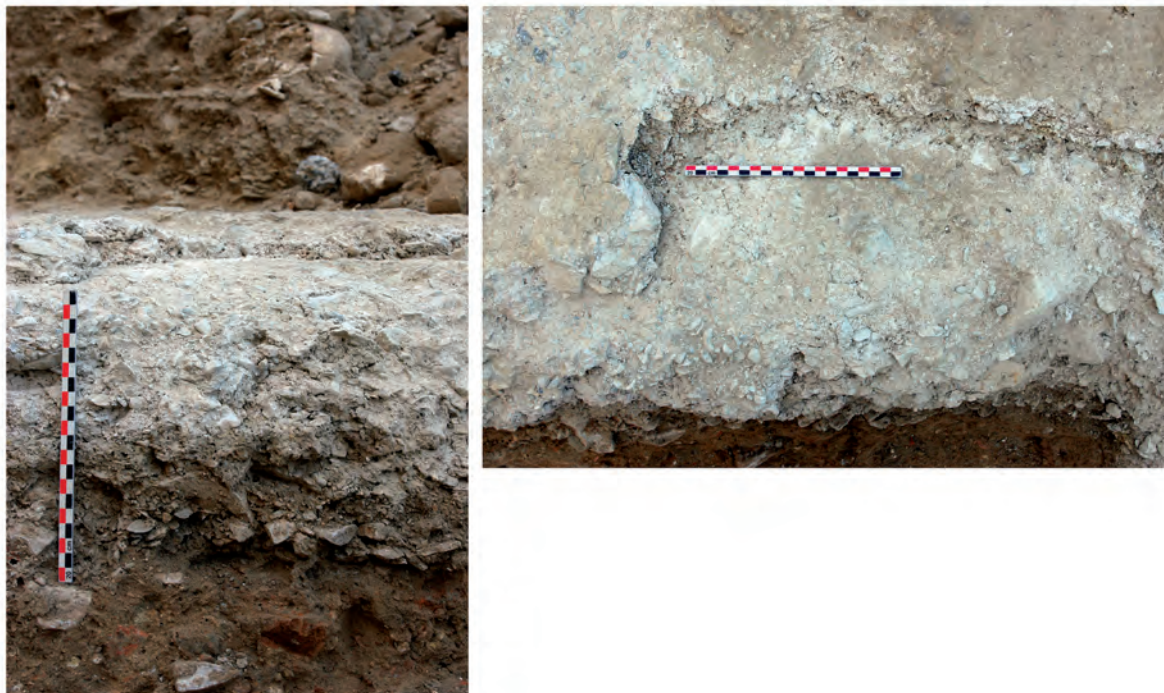
Fig. 314 _ Détail du sol SL1264 : sa surface initiale et au-dessus la chappe de ragréage. Cl. O. Maufra/Inrap. [Photo no 1772a].
