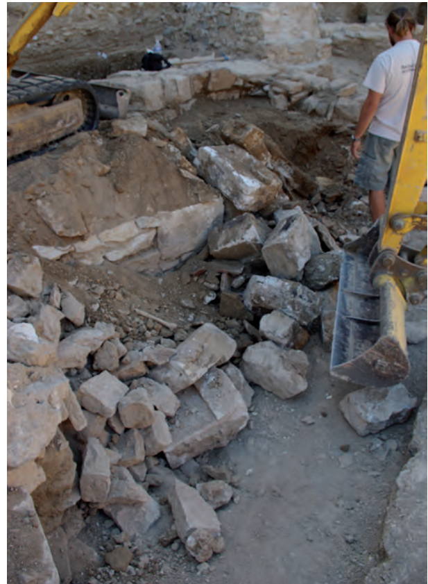
Fig. 6 : les blocs modernes en remploi dans le mur MR1083, observés lors de sa démolition. Cl. O. Maufras/Inrap. [Photo n° 571b].
