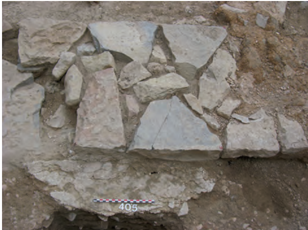
Fig. 37 : la fondation du mur MR2055 et du niveau de sol de chantier en mortier US 2100. Cl. M. Rochette/Inrap. [Photo n° 405].
