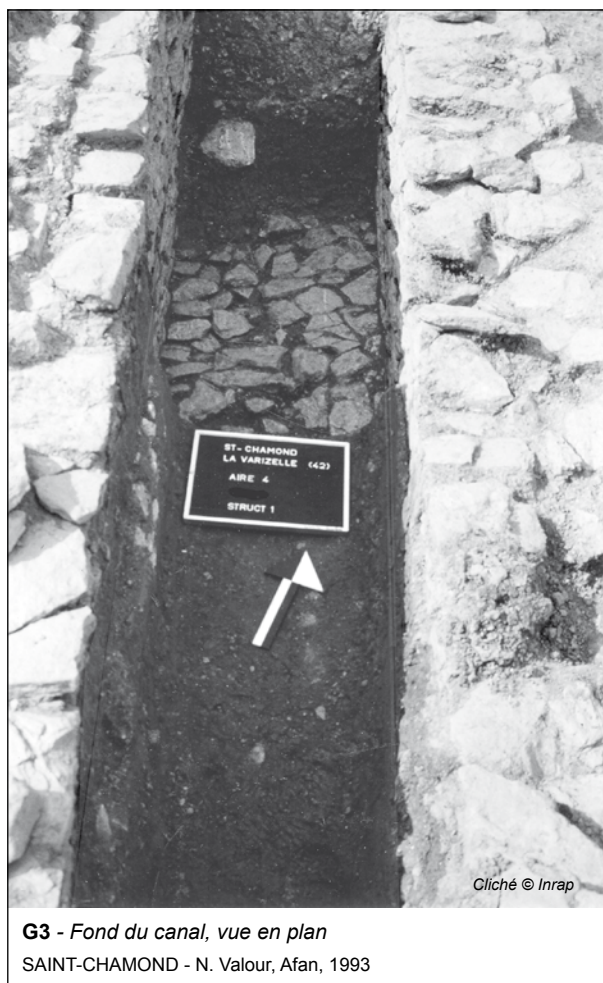
Fig. 19. Les fondations, passages enterrés, aqueduc du Gier, la base du canal.
