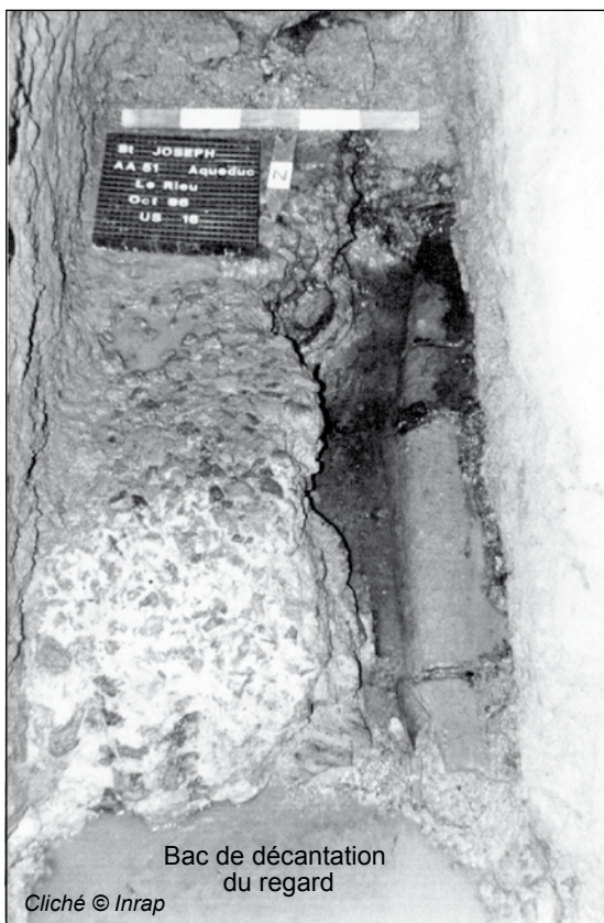
G12 - Captage médiéval (IX e - XII e s.) installé au travers du béton de fond de canal
