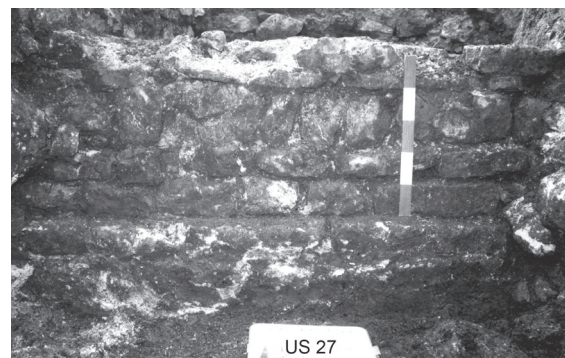
Fig. 351 - Place des Frères-Fournet, sondage S 2 : mur US 27 en élévation (cliché : M. Guyon).
