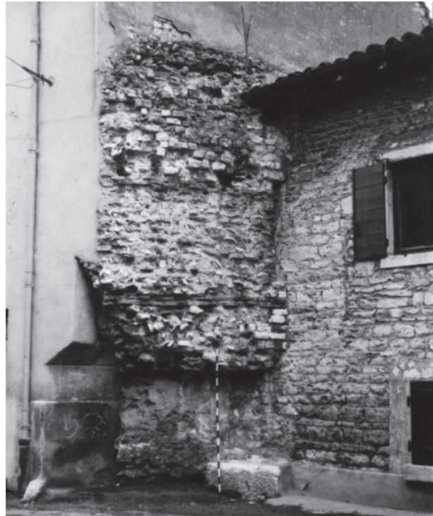
Fig. 366 - Bloc de grand appareil en réemploi dans la partie basse de la tour n° 6; la large saignée au-dessus du bloc témoigne de la récupération d'autres blocs (cliché J. Gruyer: archives R. Tenu).
