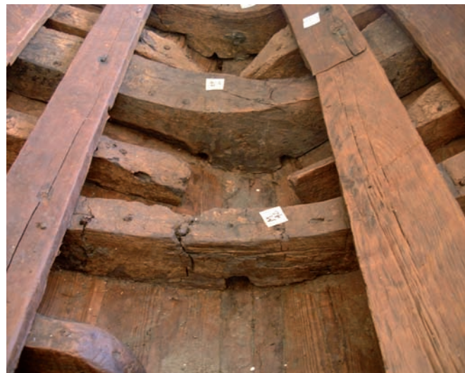
Fig. 23: Vue de la face arrière des varangues M42 (au premier plan) et M44. La base de M42 est percée d'un anguiller rectangulaire situé au niveau de la quille, tandis que M44 présente deux anguillers triangulaires au niveau des galbords qui amorcent ici la remontée vers la proue (cliché G. Boetto).
