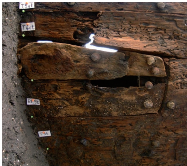
Fig. 33 : La planche de réparation Rt5t (cliché G. Boetto).
