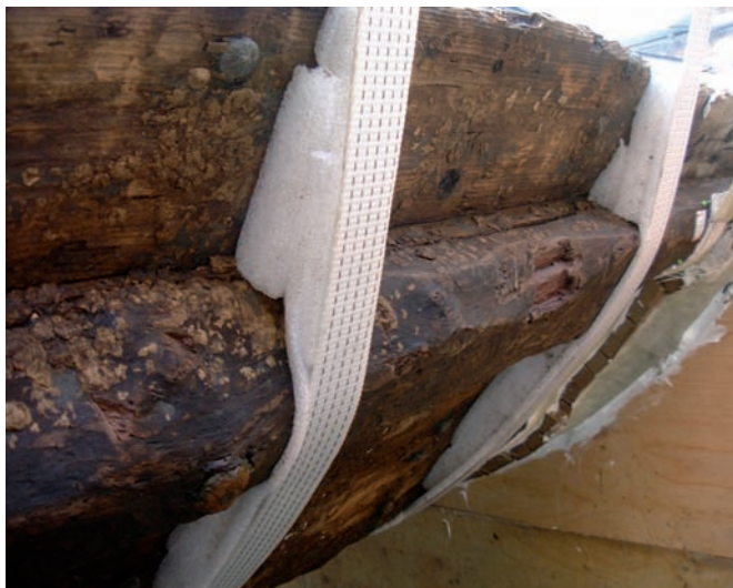
Fig. 34: La préceinte T17t avec son élément de doublage Rt8t (cliché G. Boetto).
