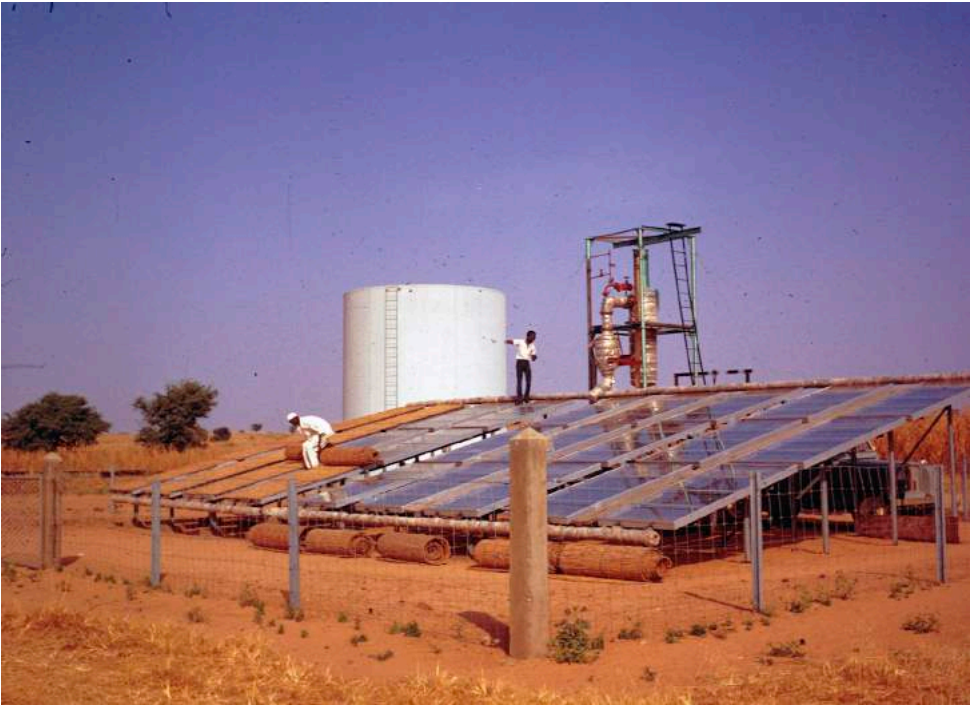
La première pompe de village de la Sofretes, 66 m 2 de capteurs, 8 m 3 /h pour une profondeur de 12 à 20 m, à Bossey Bangou, près de Niamey, en 1969.
