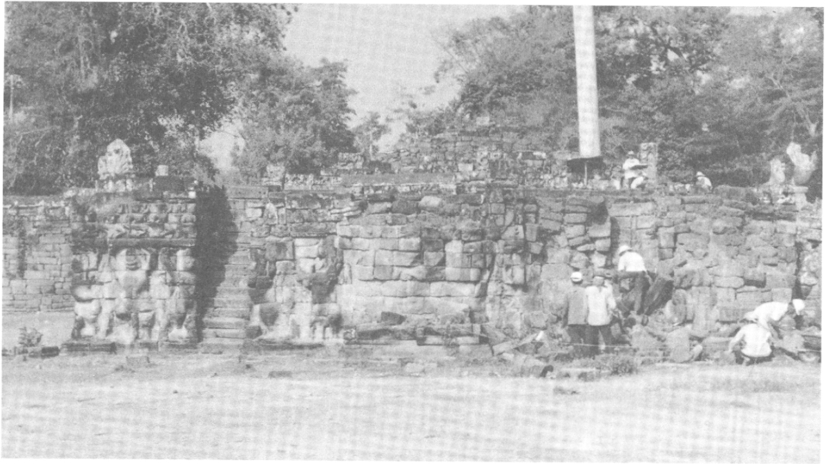
Photo 1 : Face orientale du perron nord avant dégagement, mars 1996.
