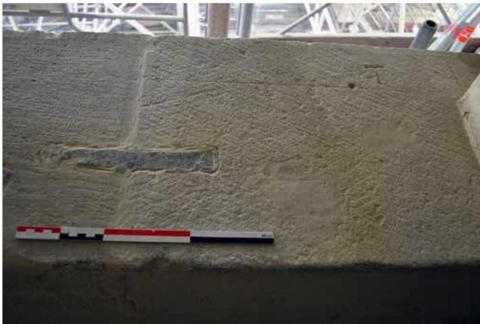
**ill. 29.** *Abside, travée A (UM 2), triforium, arcature ouest, appui du mur-babut, agrafe en fer scellée au plomb.*
