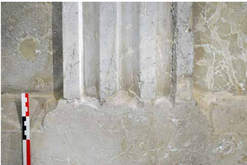
**Fig. 83 :** Chœur, travée B sud (UM 3), arcature trilobée, pilastre médian est, défaut d'alignement entre la base et le pilastre qui la surmonte.
