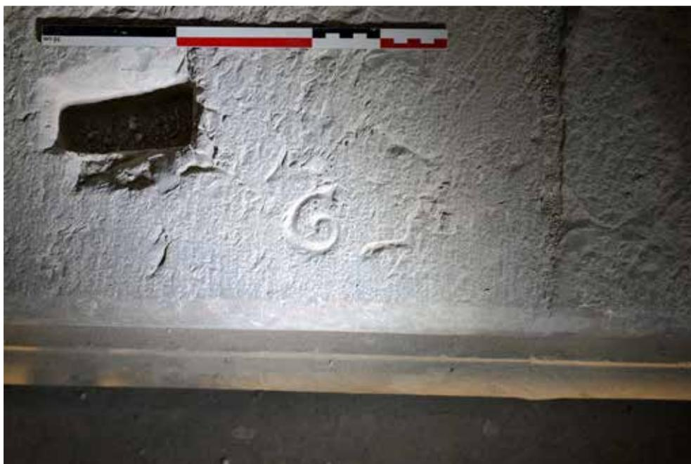
**ill. 38.** *Abside, travée G (UM 2), appui des lancettes marque lapidaire d'identification «G» sur le lit d'attente du bloc inférieur mouluré est.*
