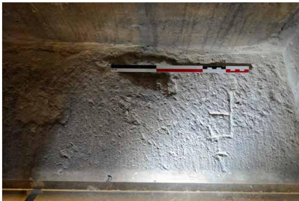
**ill. 37.** *Abside, travée F (UM 2), appui des lancettes, marque lapidaire d'identification «F» sur le lit d'attente du bloc inférieur mouluré ouest.*
