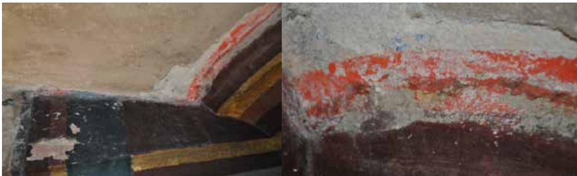
Ces trois couches stratigraphiques s'interrompent à quelques centimètres de la couronne supérieure de la voûte, où l'enduit gris a été appliqué directement sur l'appareil de la voûte.
