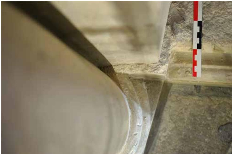
**Fig. 103** : Abside, travée E (UM 2), appui de la lancette, ébrasement côté est, détail du décalage d'ajustement en plan entre le bloc inférieur comprenant dé et base de colonne du support intermédiaire, et le bloc de l'assise supérieure, suivant la dissymétrie de l'ébrasement.
