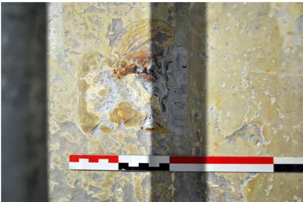
**Fig. 43 :** Chapelle Notre-Dame-du-Haut-Don, travée A sud (UM 5), vue générale d'un bloc et des vestiges d'un trou de louve et d'agrafes en fer antiques.
