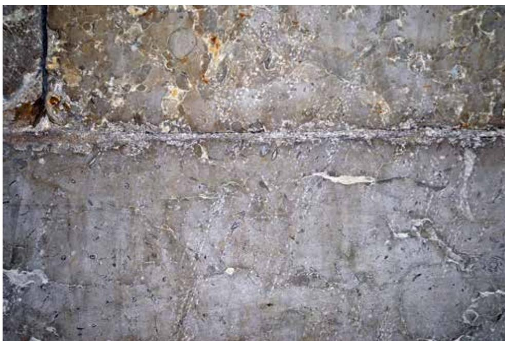
**ill.33.** Abside, travée C (UM 2), appui de la lancette, ébrasement côté sud-est, détail du décalage d'ajustement en plan entre le bloc inférieur comprenant dé et base de colonne du support intermédiaire, et le bloc de l'assise supérieure, suivant la dissymétrie de l'ébrasement.
