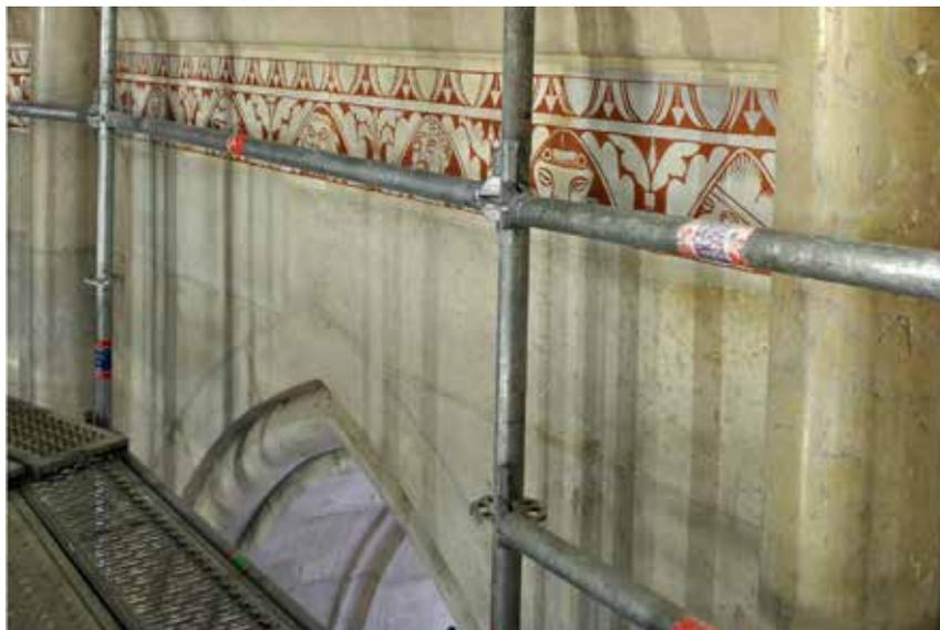
**ill. 22.** Abside, sommet de l'arc brisé du pan F, découpe du lit de pose du bloc de l'assise supérieure.
