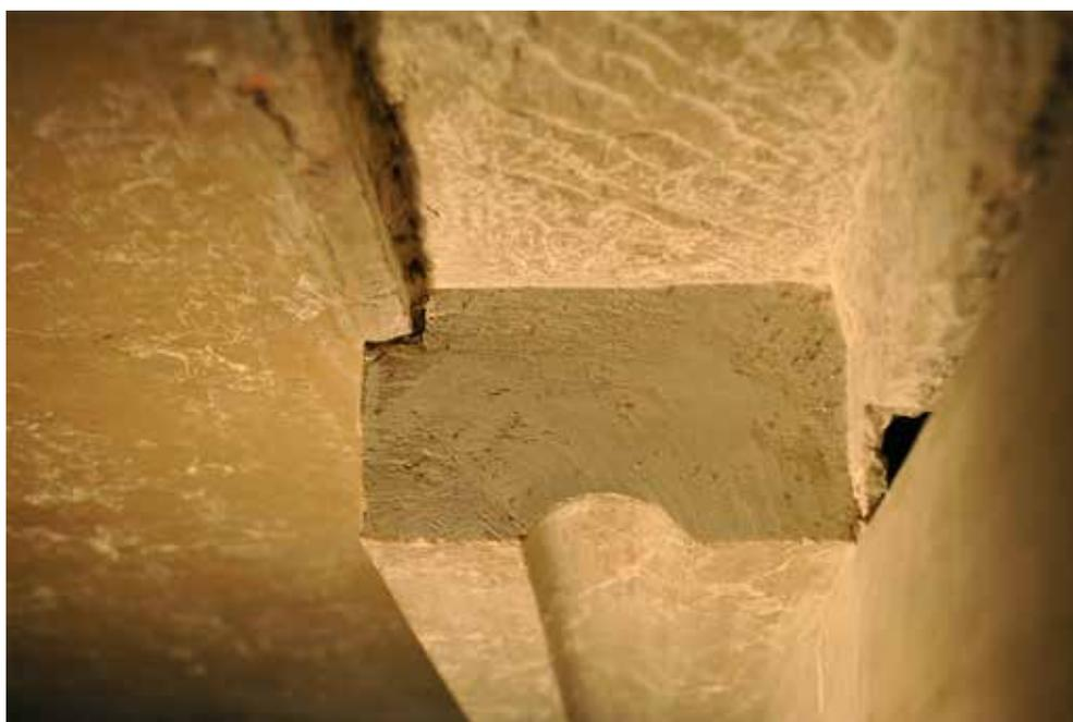
**Fig. 73 :** Abside, travée C (UM 2), restauration en cours du chapiteau ES 02.014 et de la partie supérieure du pilastre latéral.
