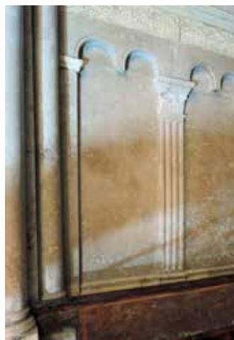
**ill. 8.** Chapelle Saint-Pierre, mur nord (UM 7), blocs monolithes constituant à la fois un orthostate et un demi-pilastre engagé.
