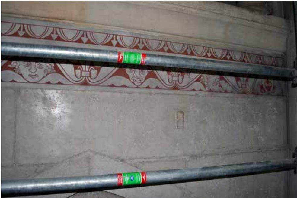
**Fig. 41 :** Abside, travée C (UM 2), dernière assise sous la frise médiane, vue de détail du bouchon de choin d'une encoche de levage antique (trou de louve).
