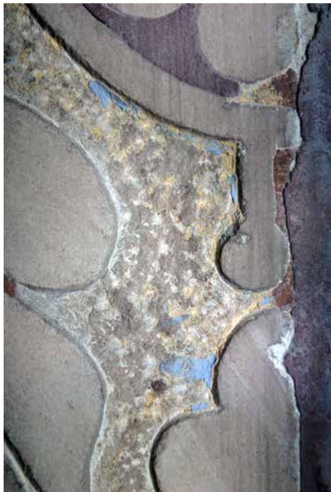
**Fig. 249 :** Abside, détail de la liaison entre la clé de voûte et l'arc doubleau de l'abside.
