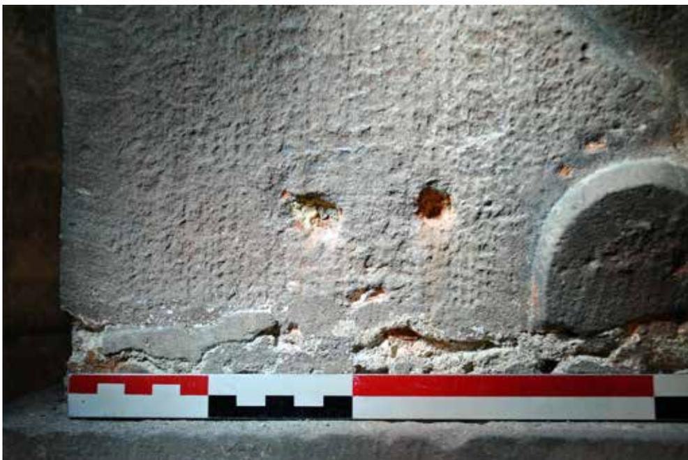
**Fig. 224** : Abside, travée A (UM 2), clair-étage, sommier d'ogive UM 2A, numérotation poinçonnée.
