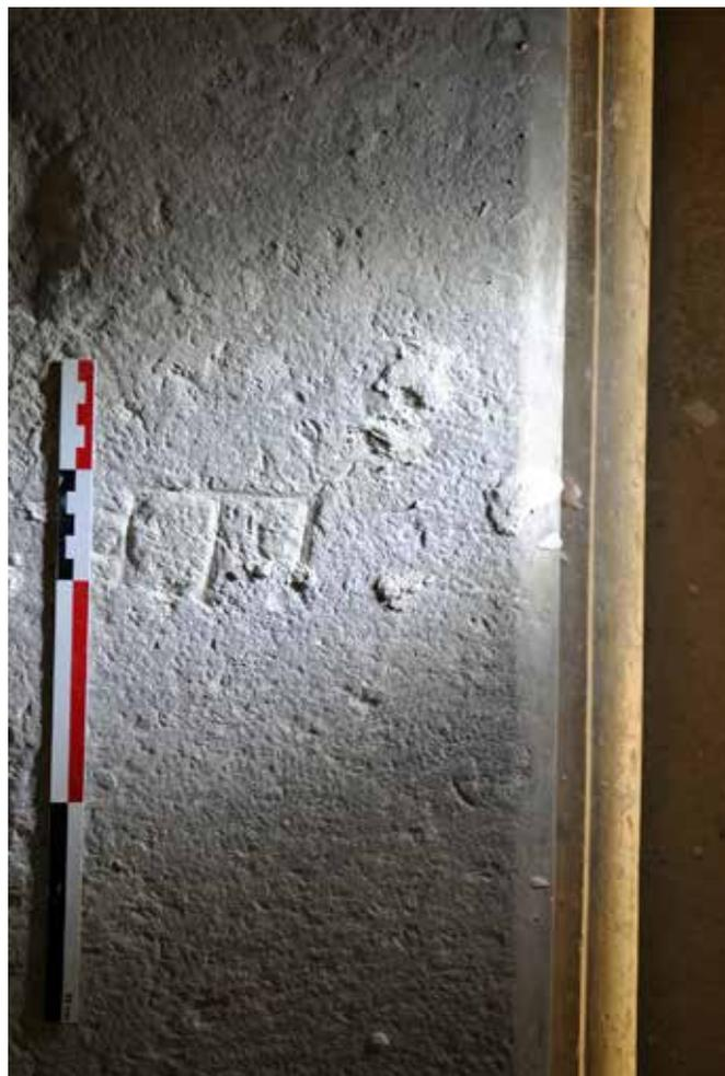
**Fig. 129 :** Absidiochambre, travée D (UM 2), appui des lancettes, marque lapidaire d'identification «D» sur le lit d'attente du bloc inférieur mouluré sud.
