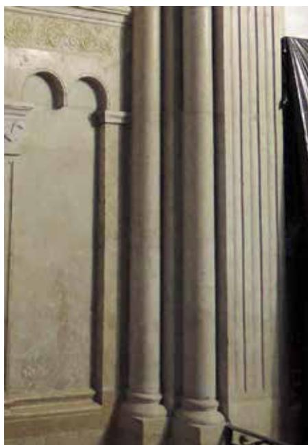
**ill. 3.** Chapelle Notre-Dame, mur sud (UM 5), bloc monolithe composant le pilastre cannelé et la colonne.
