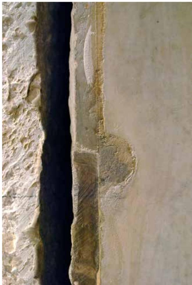
**Fig. 75 :** Abside, travée C et D (UM 2), restauration en cours du chapiteau ES 02.014 et de la partie supérieure du pilastre latéral, vue de profil de la section en U de l'unique bloc formant les deux pilastres latéraux et de la section en T du pilastre central.
