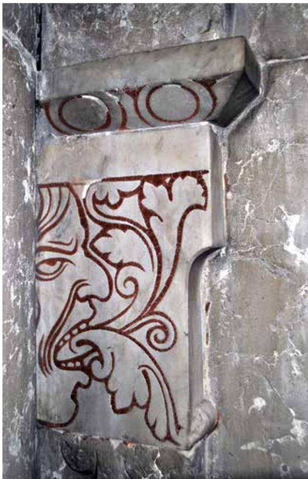
ill. 26. Chœur, travée B nord (UM 1), arcature trilobée ouest, ressaut de la section en T des blocs du chapiteau ES 04.002, encastés dans le bloc formant pilastre et fond de l'arcature.
