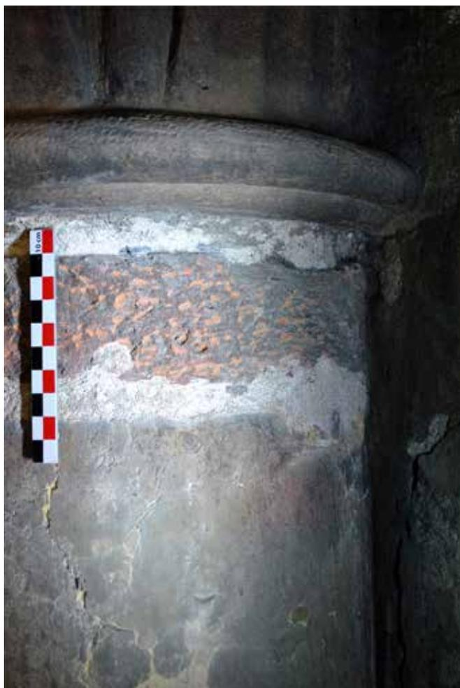
ill. 52. Abside, travée F (UM 2), triforium, sommet de la colonne engagée UM 2F/UM 2G, court cylindre de terre cuite inséré entre le lit d'attente de la colonne et le lit de pose du chapiteau.
