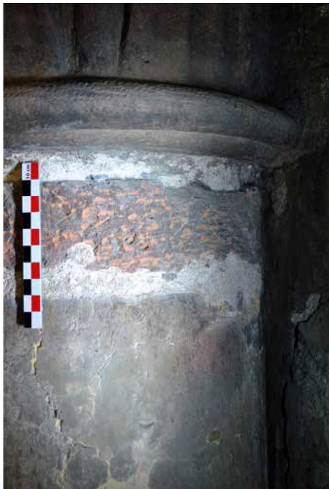
**Fig. 220** : Chœur, quartier de voûte sud, partie ouest, appareil de tuf.
