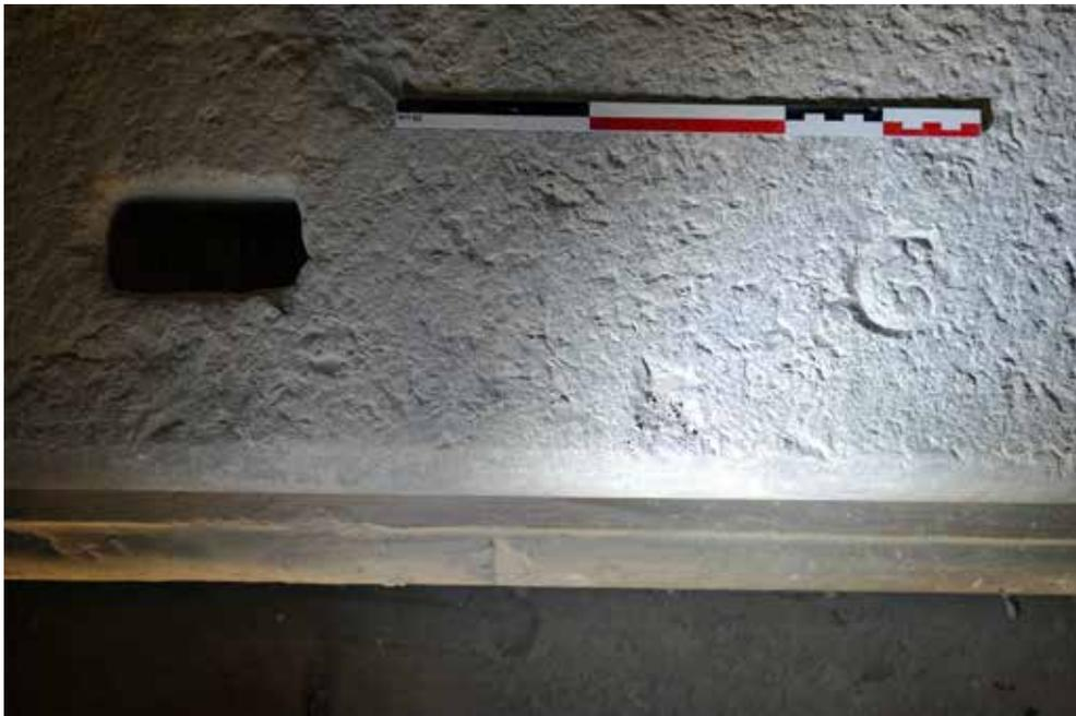
**Fig. 133** : Abside, travée G (UM 2), appui des lancettes marque lapidaire d'identification «G» sur le lit d'attente du bloc inférieur mouluré est.
