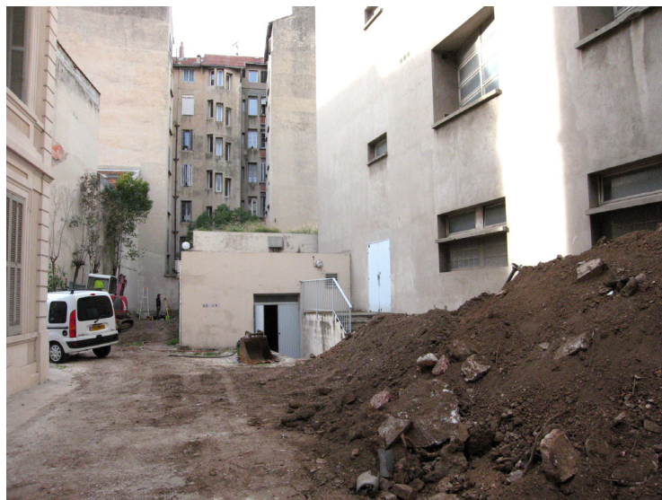
Figure 3 : Vue de la cour intérieure depuis l'est et le stockage des déblais.
