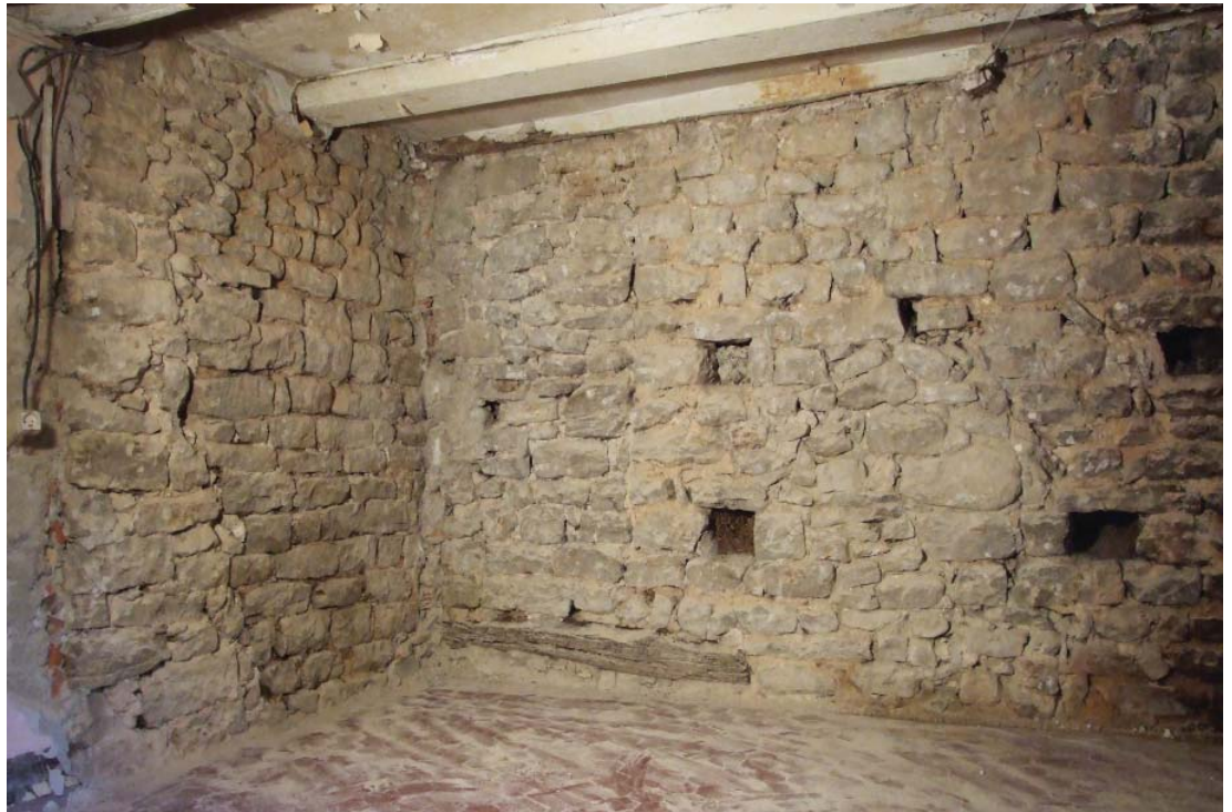
Fig. 15 : Zone 1, murs MR1001 et MR1002 avec le linteau en bois de l'ouverture du premier étage (ras du sol) et l'ouverture du deuxième étage, bouchée (PR1019).
