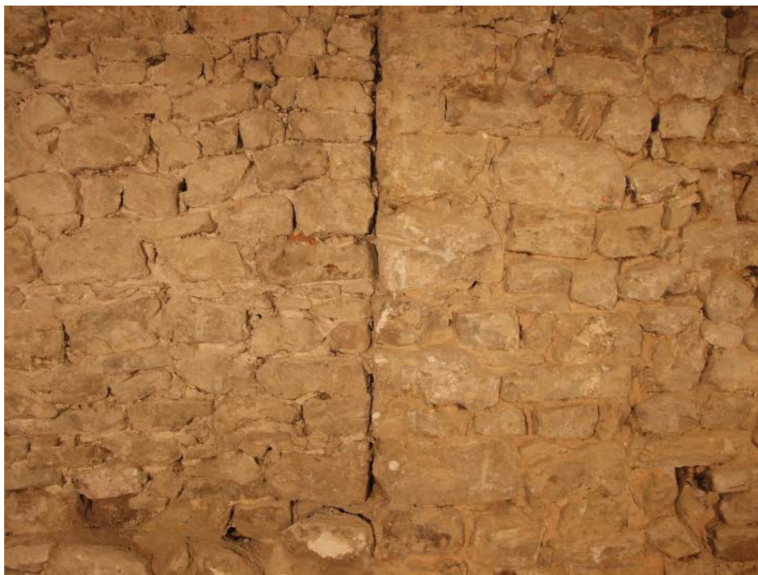
Fig. 13 : Mur MR1002 (parement ouest)
