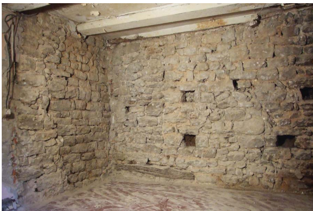
Fig. 14 : Zone 1, troisième étage, mur MR1001 avec le linteau en bois de l'ouverture du deuxième étage
