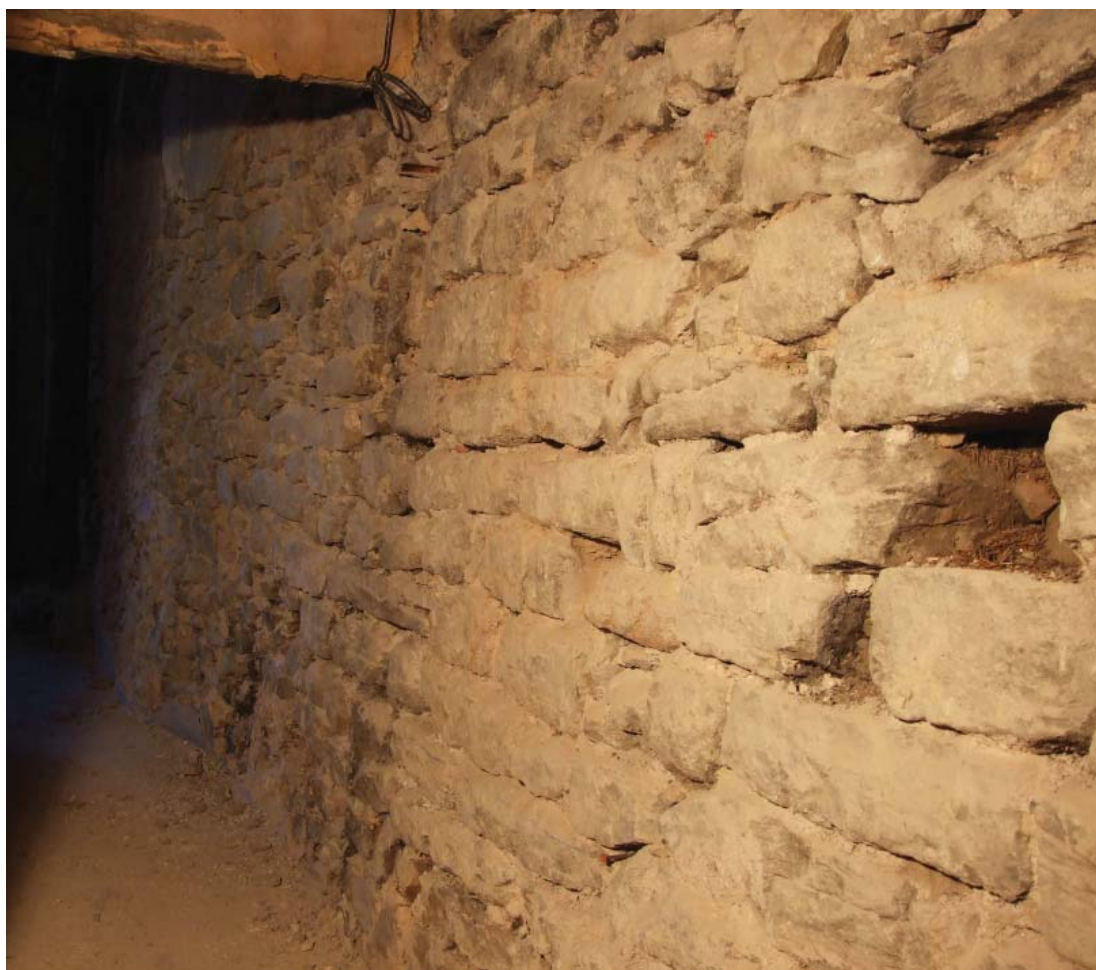
Fig. 44 : Mur MR2039, parement ouest, vue depuis le sud
