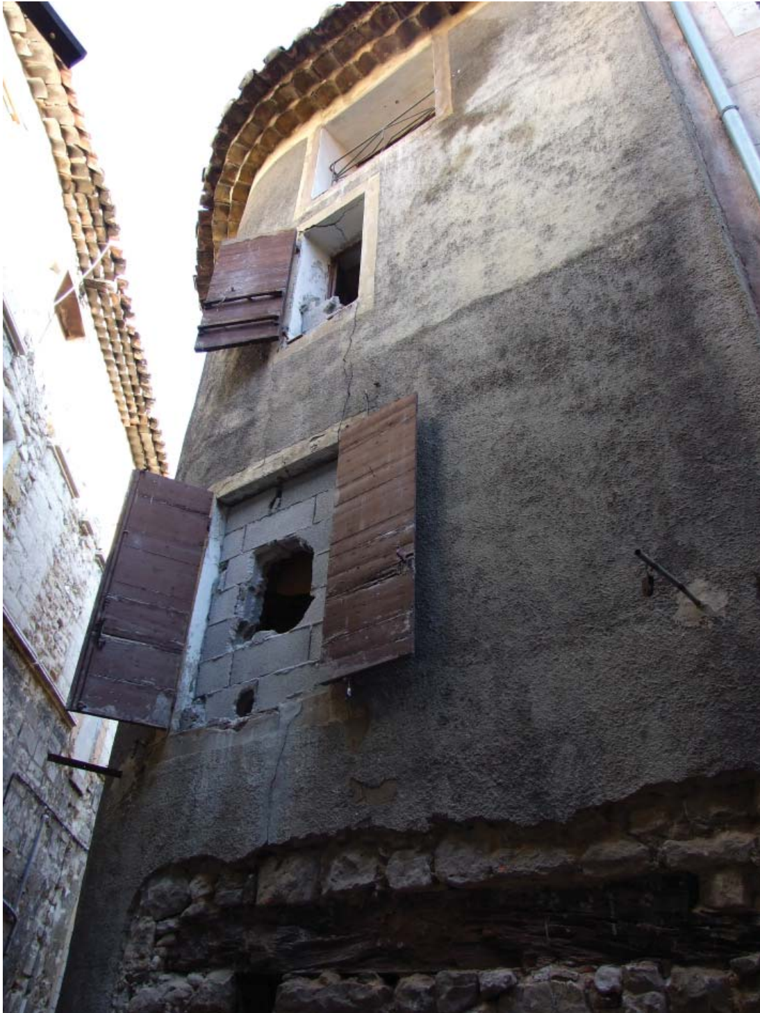
Fig. 8 : Zone 1, façade ouest (parcelle 122)
