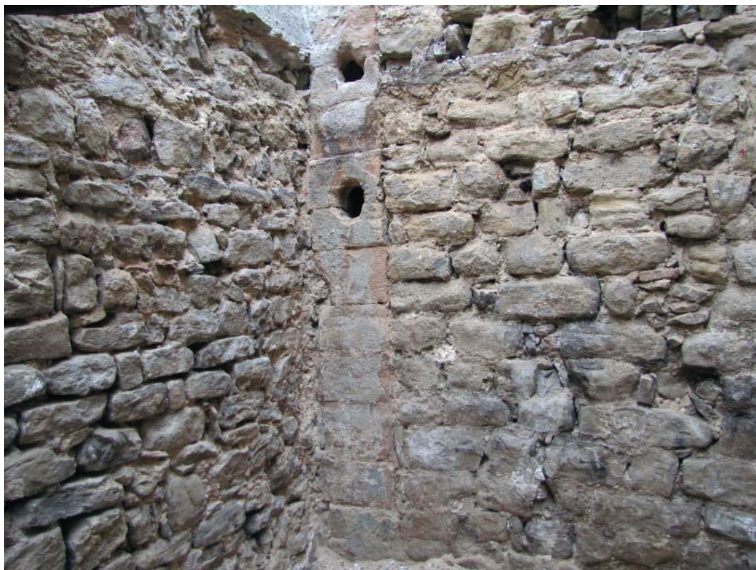
Fig. 38 : Parcelle 747, conduite en pierre et mur MR2107
