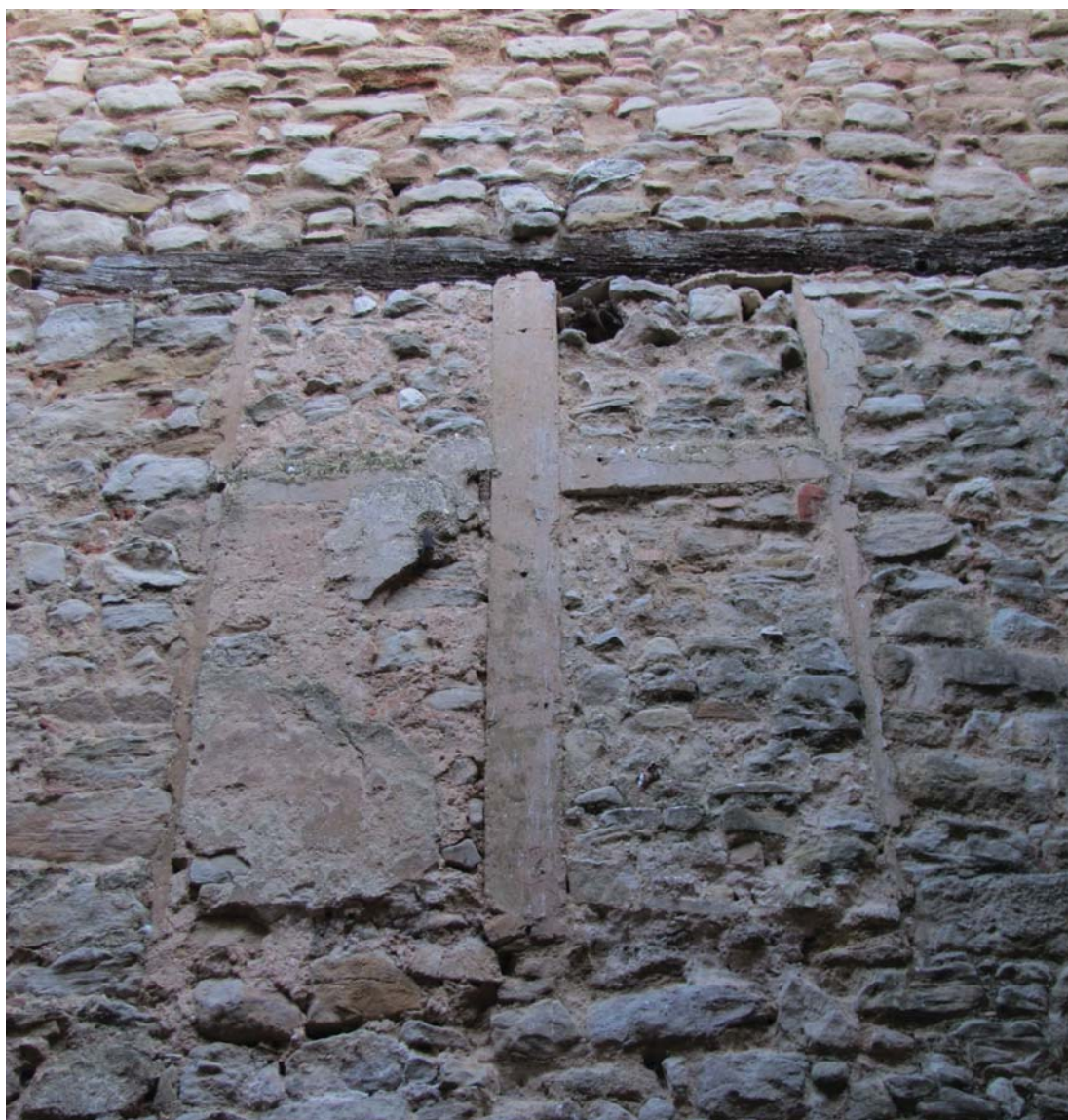
Fig. 49 : Fenêtre à meneau et traverse FN2126, parcelle 128, partie est
