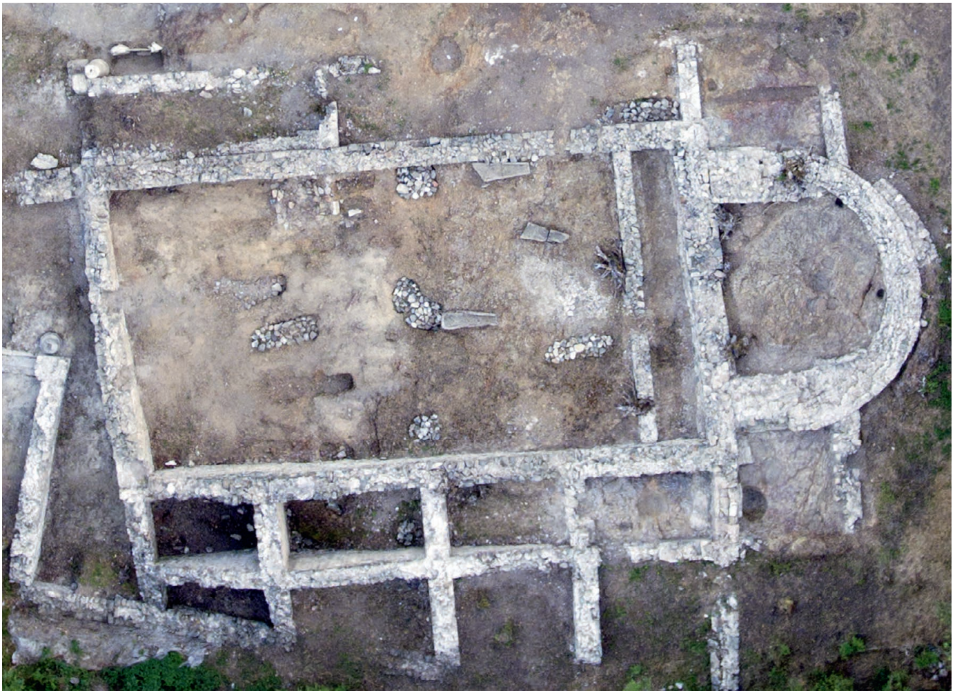
Fig. 10 Vue aérienne de l'église (cl. D. Martinez).
