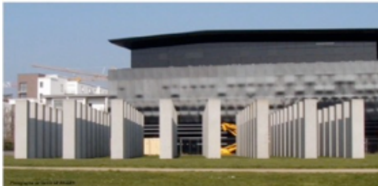
Figure 3 – L'alignement du XXI ème siècle
