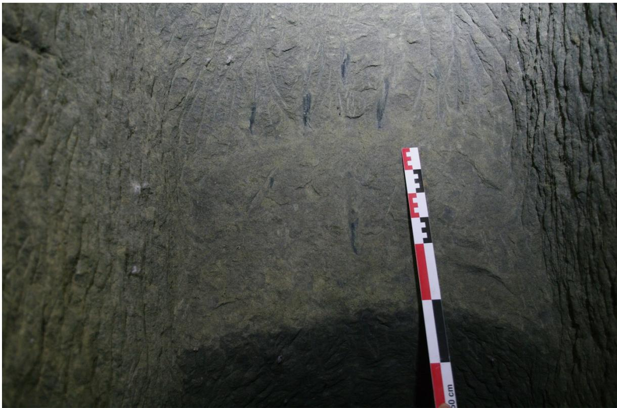
Fig. 63: Traces d'impact du pic et finitions à la broche. Cliché: L. Benoit - SDAHs - CIHAM.
