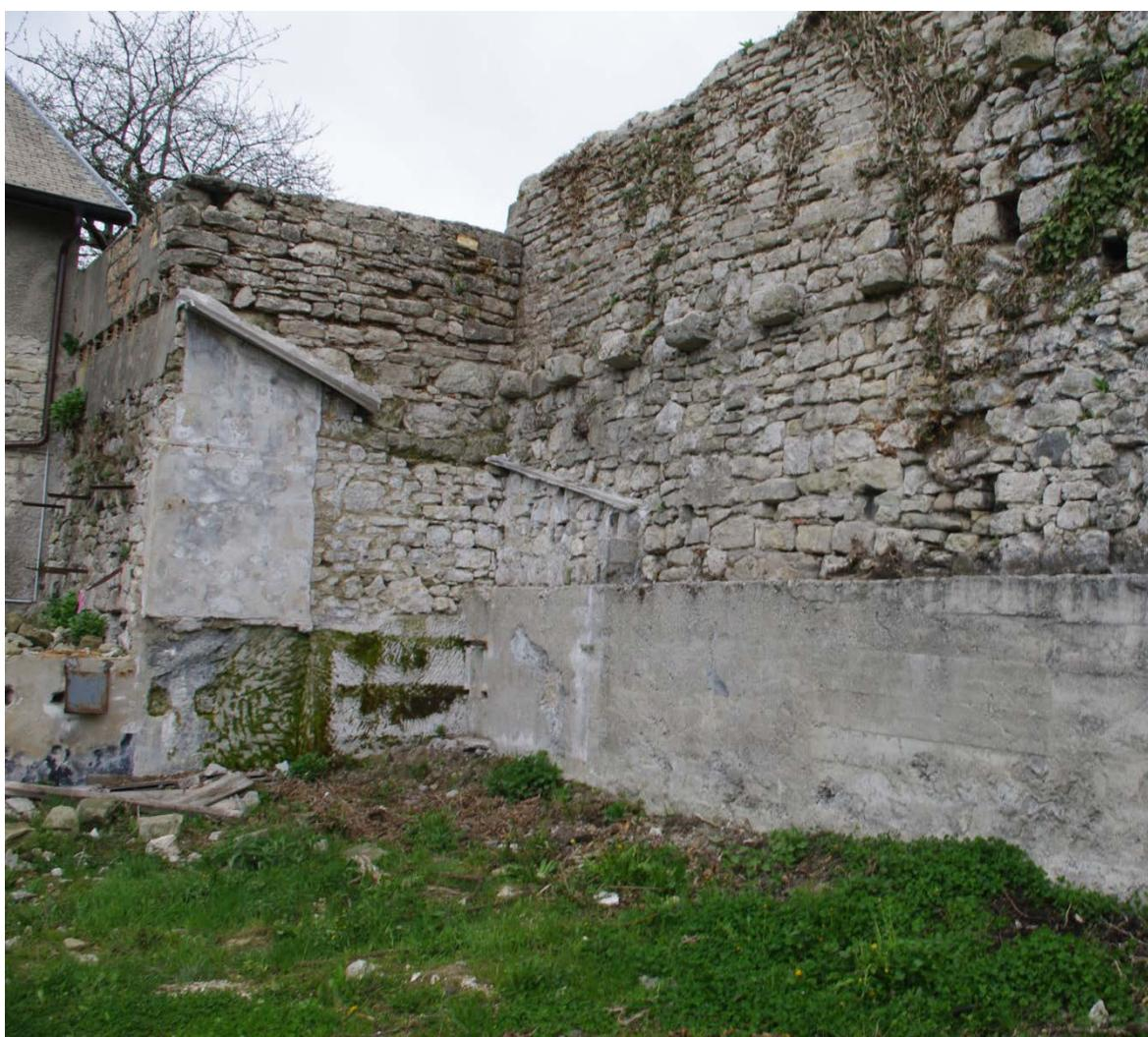
**Fig. 48:** Traces des toitures du garage. Cliché: L. Benoit - SDAHS - CIHAM.
