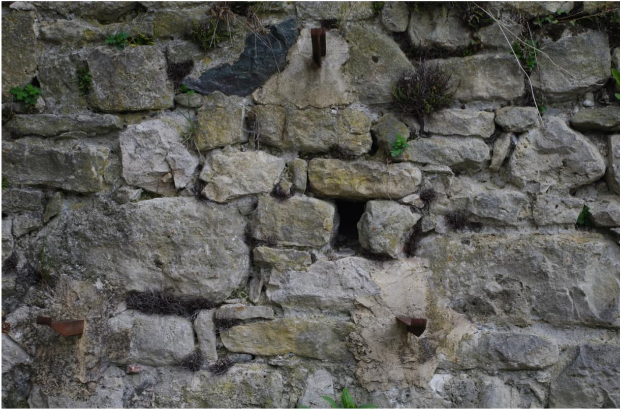
Fig. 43: Détail d'une des évacuations de M 8001. Cliché: L. Benoit - SDAHs - CIHAM.
