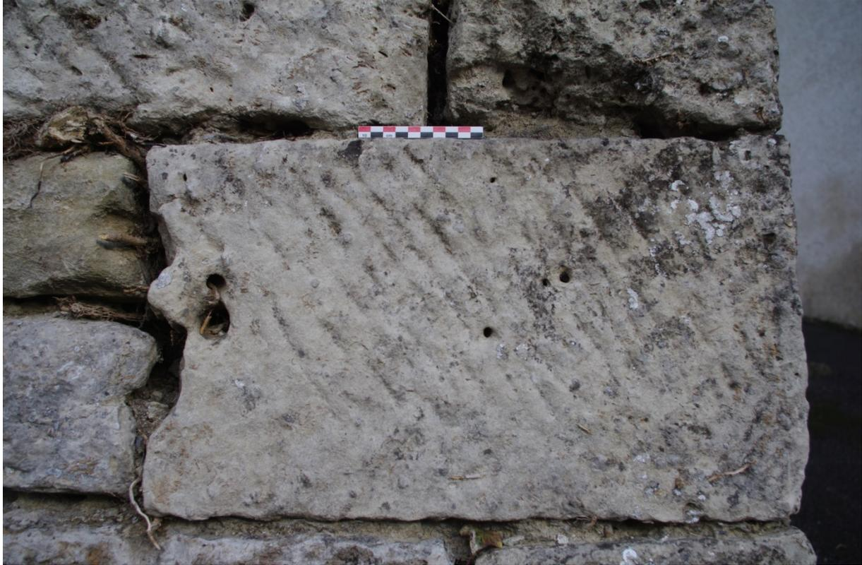
Fig. 30: Traces de tailles sur la chaîne d'angle. Cliché: L. Benoit - SDAHS - CIHAM.
