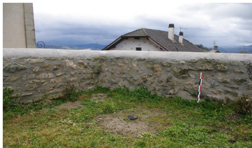
Fig. 51: Rejointoiements réalisés en 2015. Cliché: L. Benoit - SDAHS - CIHAM.
