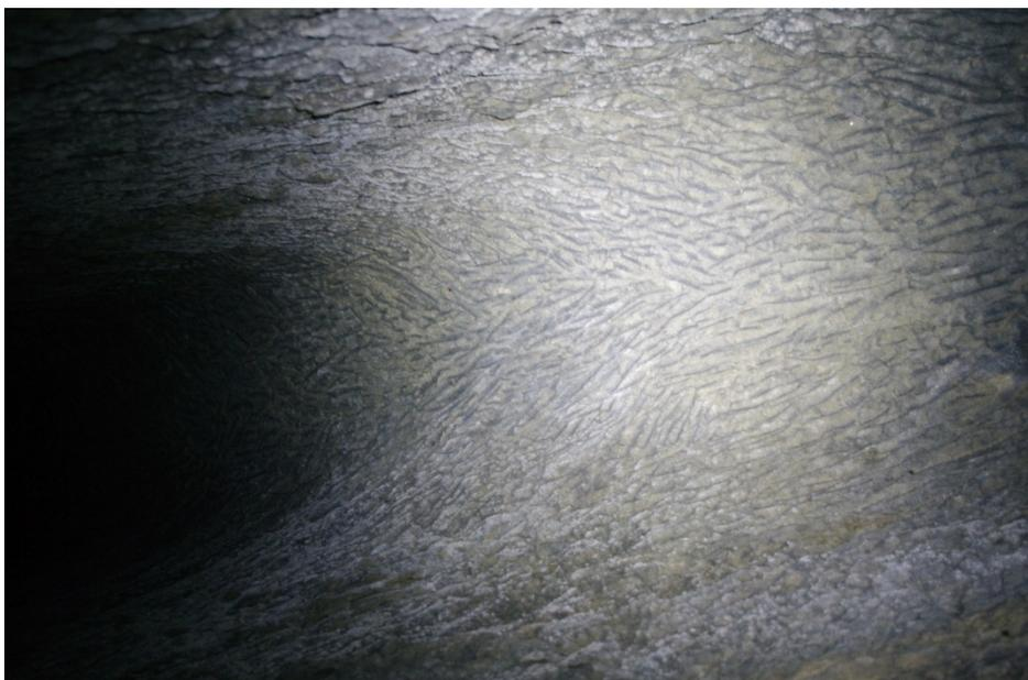
Fig. 60: Traces de taille visible sur l'intrados. Cliché: L. Benoit - SDAHS - CIHAM.
