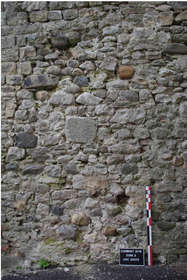
Fig. 34: Parement USC 80075 lié à la mise en place de la citerne. Cliché: L. Benoît - SDAHS - CIHAM.
