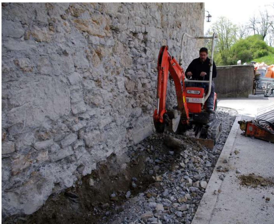
Fig. 21 : Tranchée réalisée au pied du mur nord-ouest. © Département de la Haute-Savoie / L. Ceci.
