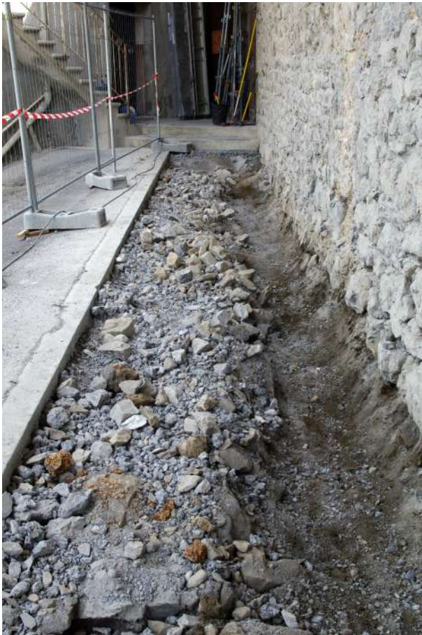
Fig. 61 : Tranchée réalisée au pied du mur nord-ouest. © Département de la Haute-Savoie / L. Ceci.
