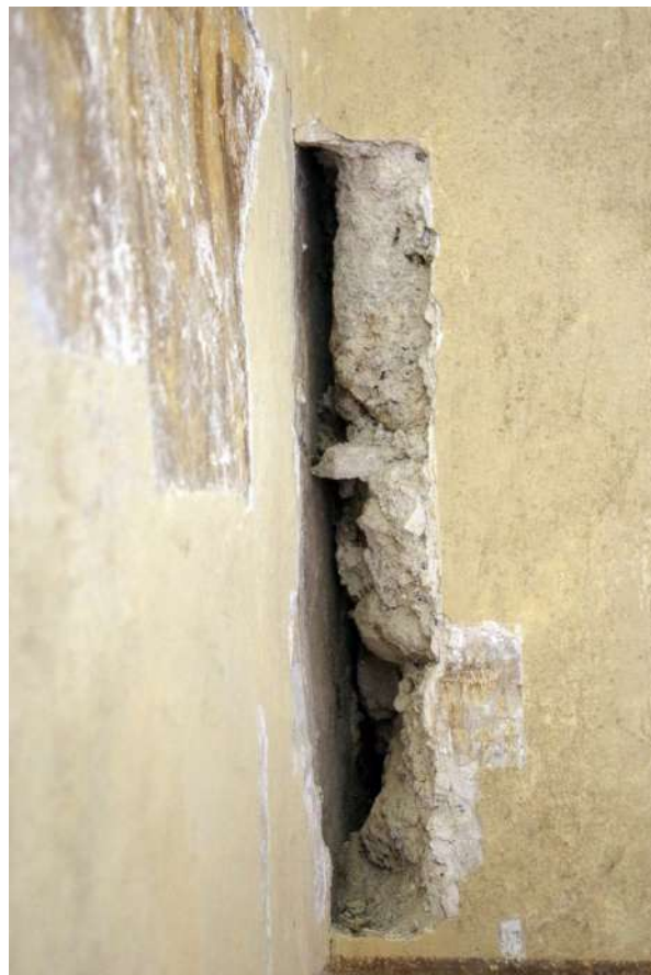
Fig. 68 : Mur qui s'appuie contre le mur de la première phase de construction. © Département de la Haute-Savoie / L. Ceci.
