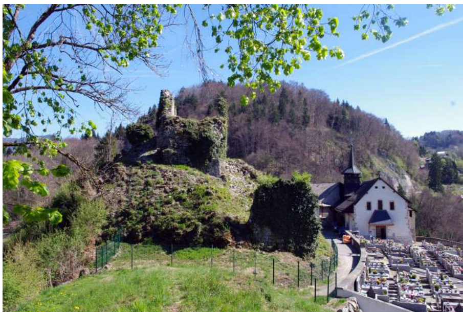
Fig. 14 : Vue de l'ensemble du site castral depuis « Le Cuar » : ruines du château, cimetière, église et presbytère. © Département de la Haute-Savoie / L. Ceci.
