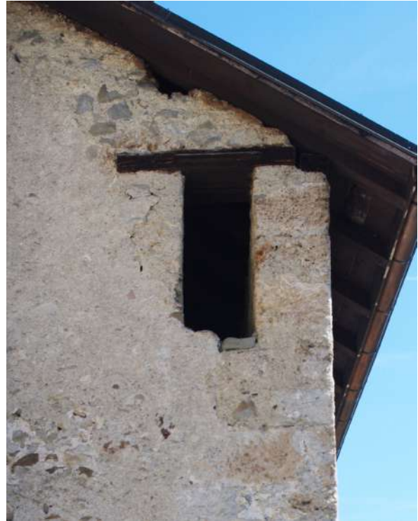
Fig. 42 : Ouverture au-dessus des chapelles latérales. © Département de la Haute-Savoie / L. Ceci.
