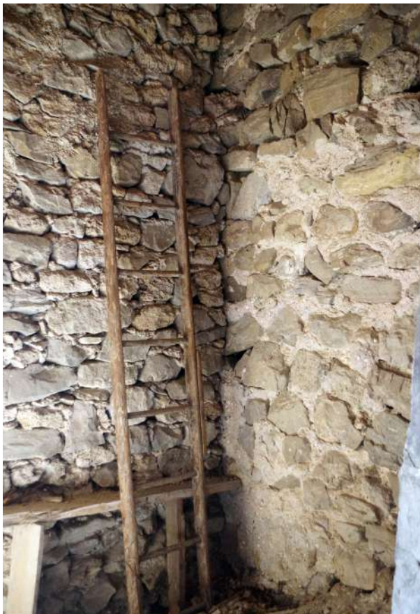
Fig. 43 : Mur que s'appuie contre l'ancienne façade situé au-dessus des chapelles latérales et ancienne fenêtre. © Département de la Haute-Savoie / L. Ceci.
