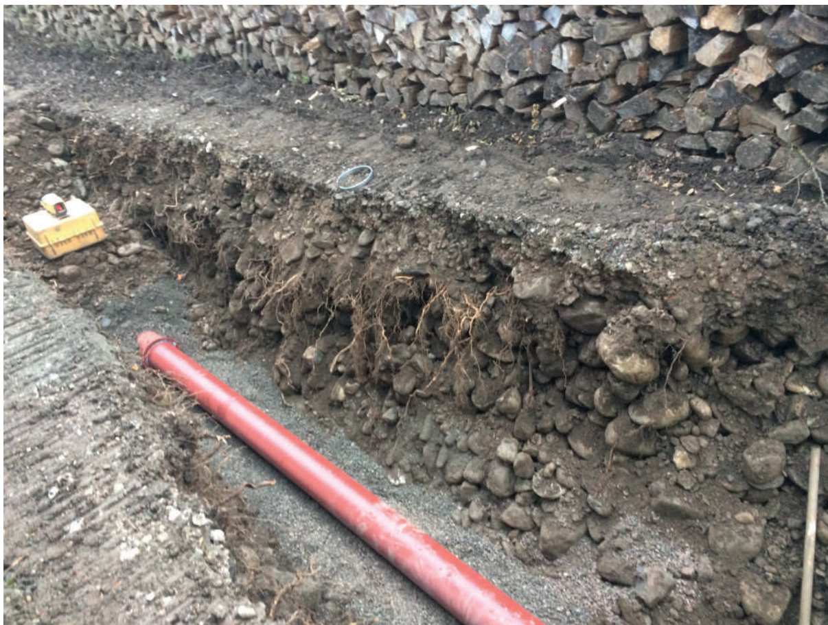
Fig. 18 : Vue de la tranchée n°2. Cliché : L. Benoit..
