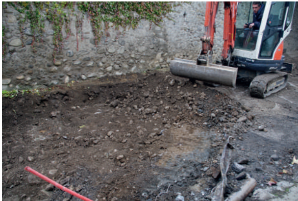
Fig. 35 : Décapage de surface. Cliché : L. Ceci.
