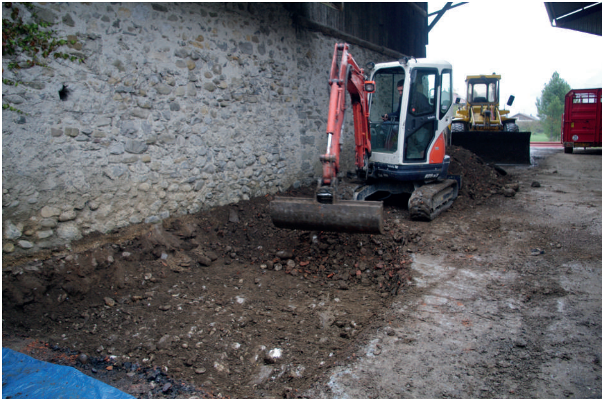
Fig. 8 : Suivi des travaux de réseaux. Cliché : L. Ceci.
