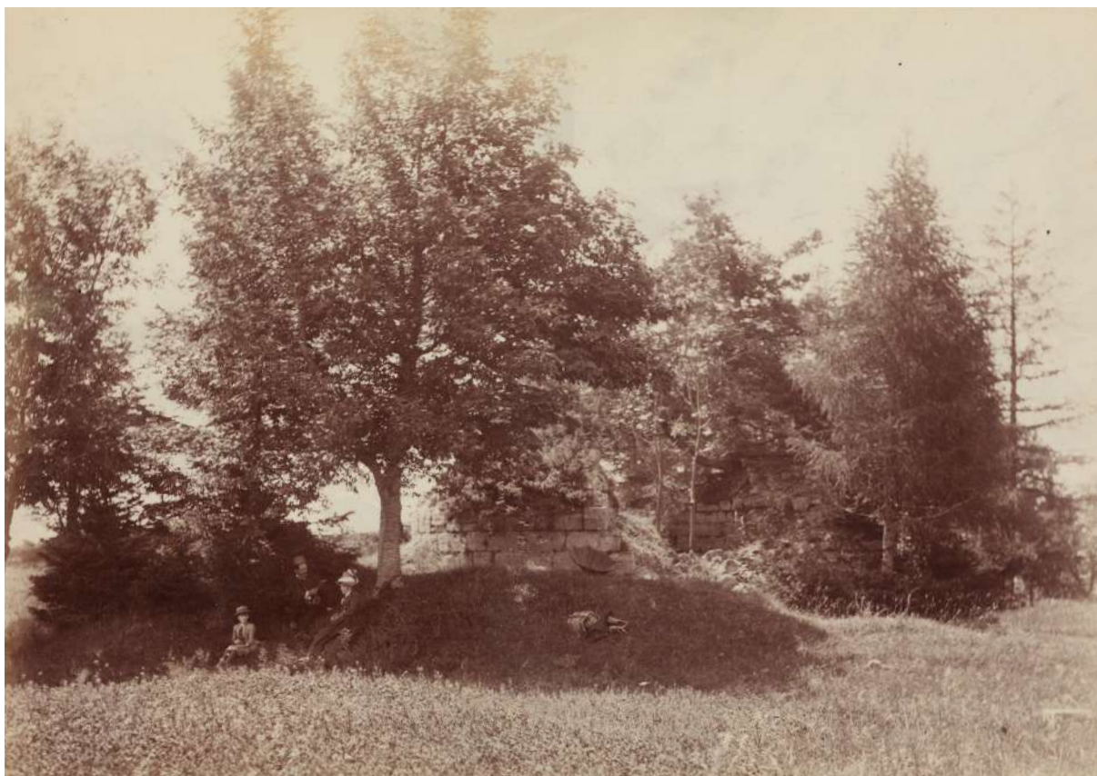
Fig. 18 : Vue des vestiges de la tour maîtresse encore hors sol. Cliché : E. Bovier ; Archives Départementales de la Haute-Savoie, 52 Fi 94.
