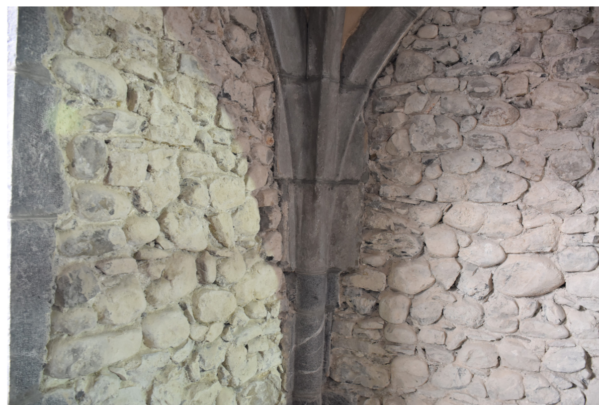
Fig. 38 : Liaison entre les murs de la chapelle et départ de la croisée d'ogive. Cliché : L. Benoit (UAPB).
