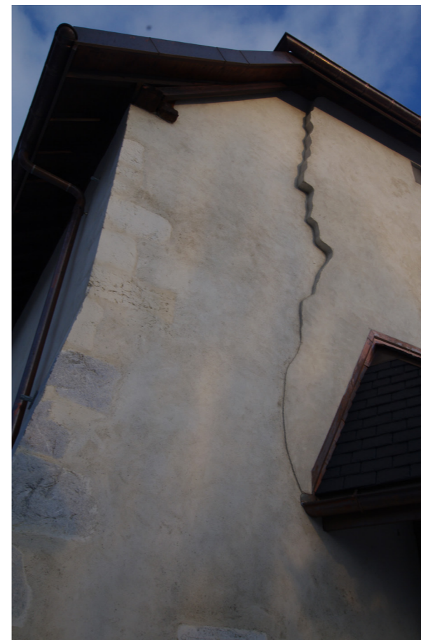
Fig. 47 : Liaison entre le mur de façade et le mur gouttereau nord. Cliché : L. Benoit (UAPB).
