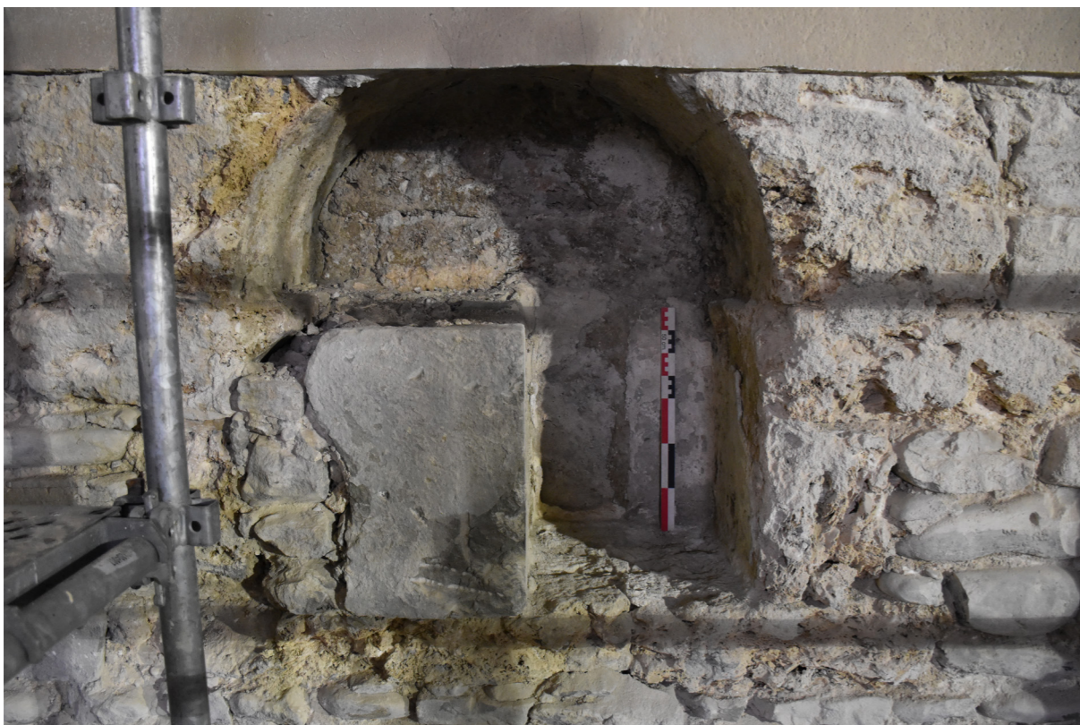
Fig. 26 : Ouverture FEN 2049 partiellement débouchée. Cliché : L. Benoit (UAPB).
