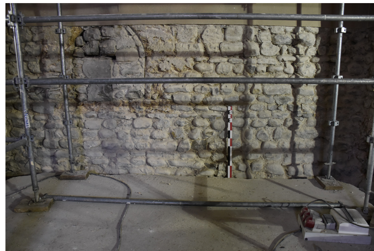
Fig. 24 : Premier état de construction (USC 20016) sur le mur gouttereau sud. Cliché : L. Benoit (UAPB).
