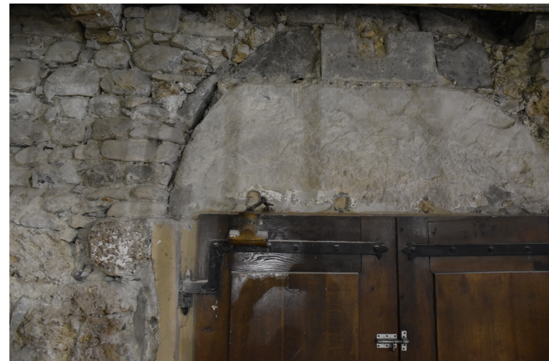
Fig. 44 : Encoche présente à l'arrière du tympan. Cliché : L. Benoit (UAPB).
