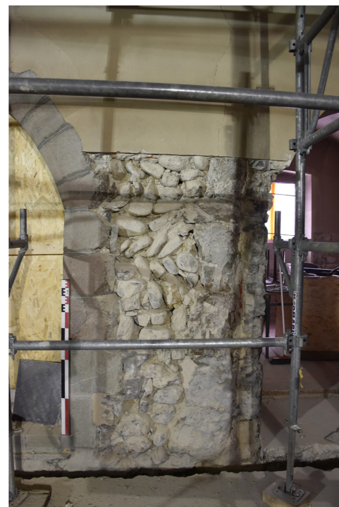
Fig. 31 : Parement USC 20020 venant boucher une ancienne ouverture. Cliché : L. Benoit (UAPB).
