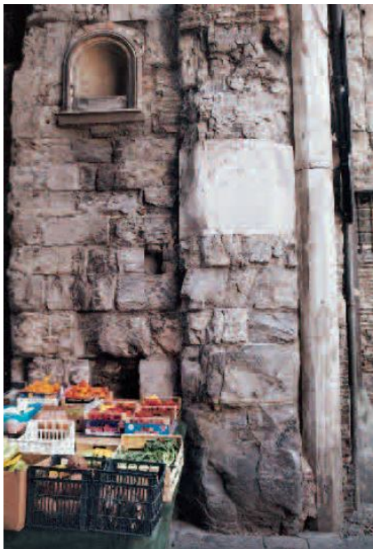
Figura 9 - Particolare della muratura della Porta dei Vacca a Genova
