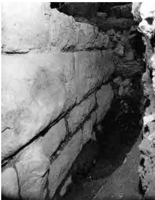
Figura 8 - Muratura in opera quadrata e lieve bugnato del molo di S. Marco
