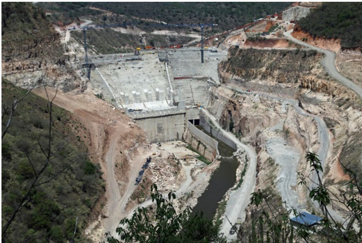
Le chantier du barrage du Zapotillo
