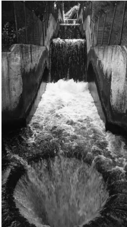
En Av. Acueducto, Comunidad de San Bartolito en el municipio de Huixquilucan)
