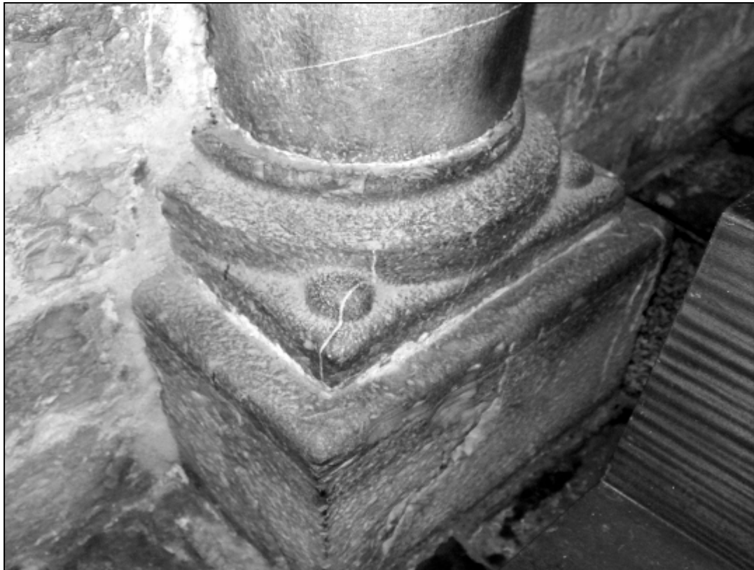
Doc. 28. Base de colonne engagée à griffes (boules) d'angle conservée dans la nef de l'église de Pagolle.
