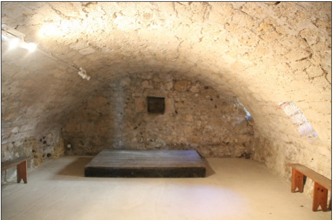
Doc. 59. Vue de la cave voûtée sous l'ancienne école. Photo S.A., 2017.
