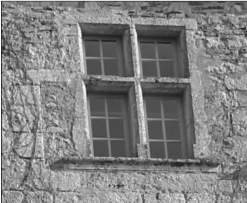
Doc. 51 et 52. Comparaison des fenêtres nord et sud du bâtiment E. Noter l'appui trop large et les traces d'une fenêtre médiévale plus ancienne sur la photo du bas (face nord). Photos S.A. 2018.
