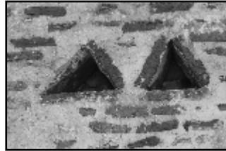
Doc. 126. Ces deux ouvertures triangulaires placées sous une fenêtre bouchée (H25), qui rappellent des boulins de pigeonnier, font partie d'une niche intérieure et ont pu servir de bouche à feu (?). Photo S.A. 2018.
