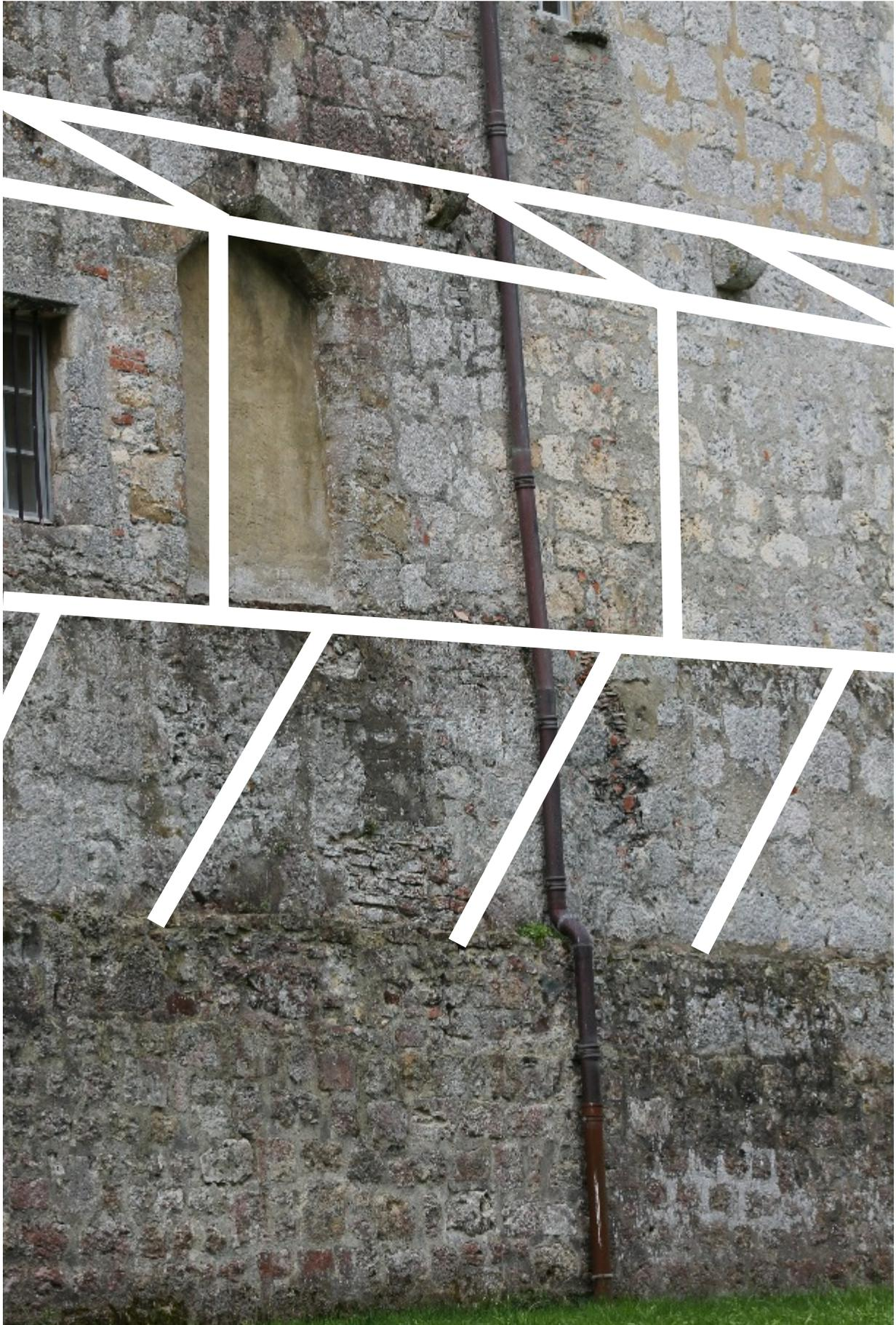
Doc. 1. Détail de la façade nord au niveau de la porte du XVII<sup>e</sup> siècle, avec une proposition de schéma d'implantation de la galerie extérieure défensive sur le mur médiéval. Photo et croquis S.A. 2018.
