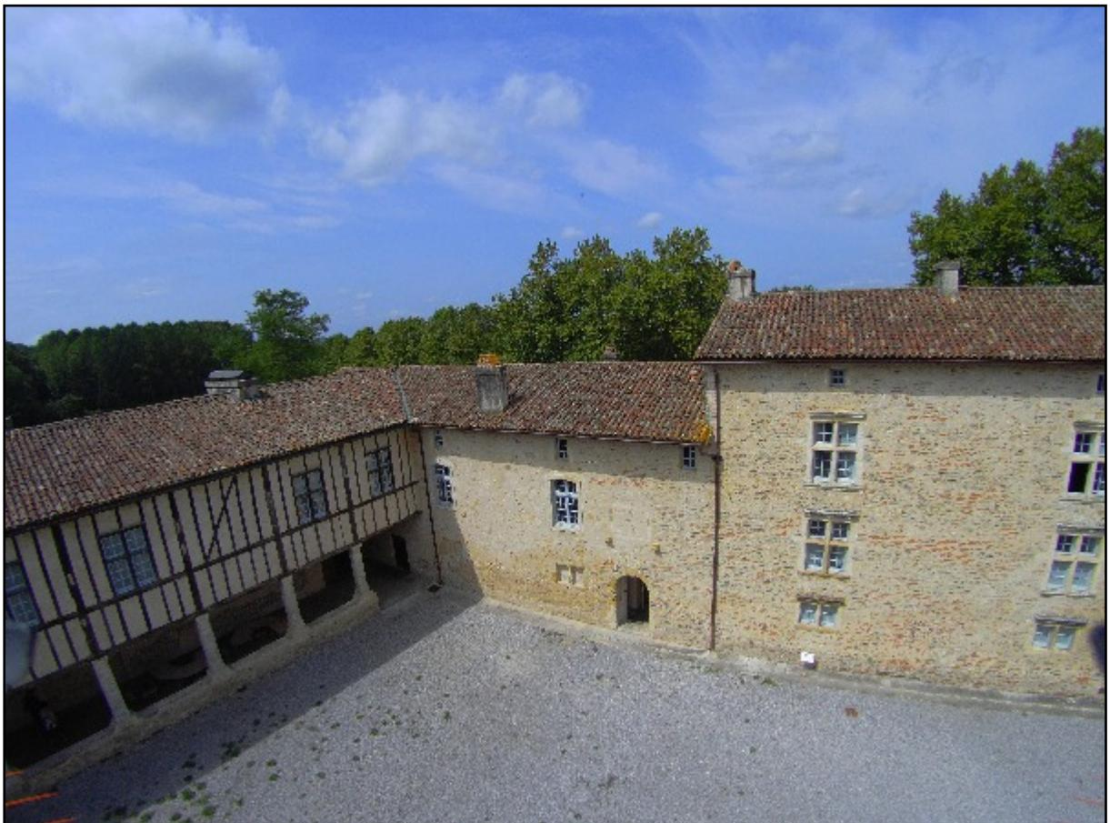
Doc. 10. Vue d'ensemble des maçonneries du XVII<sup>e</sup> siècle dans la cour : *opus incertum*, pans de bois et chaînages en calcaire. Photo SA.
