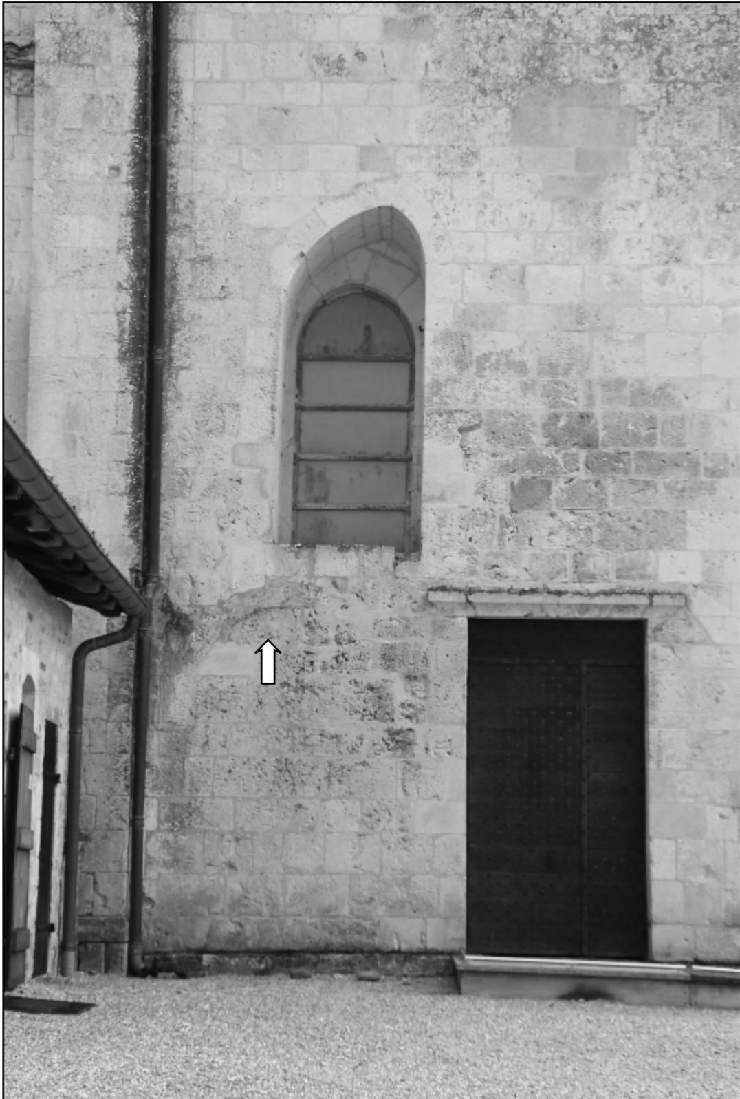
Doc. 31. La façade nord du transept de l'abbatiale. Négatif d'une voûte appuyée sur le mur au rez-de-chaussée (flèche ; ce ne peut pas être une porte, car le mur du transept est roman et non remanié) et porte d'accès à voûte rampante au premier étage : traces de l'ancienne salle capitulaire et de l'ancien dortoir ? Photo S.A. 2018.
