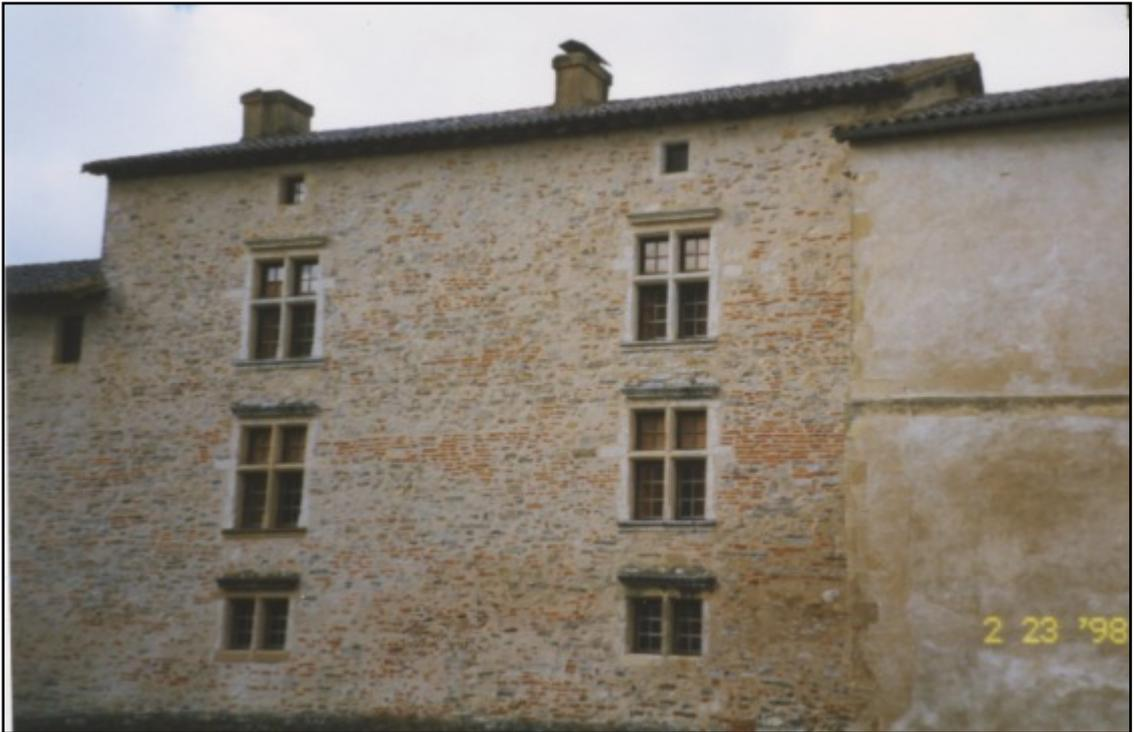
Doc. 58. La façade intérieure du bâtiment E en 1998, après destruction de l'escalier et restitution de la croisée originelle, mais avant traitement des murs au lait de chaux. L'enduit originel, encore visible sur les photographies des années 50, a été enlevé. Fonds Lafourcade, centre de documentation de l'abbaye d'Arthous.
