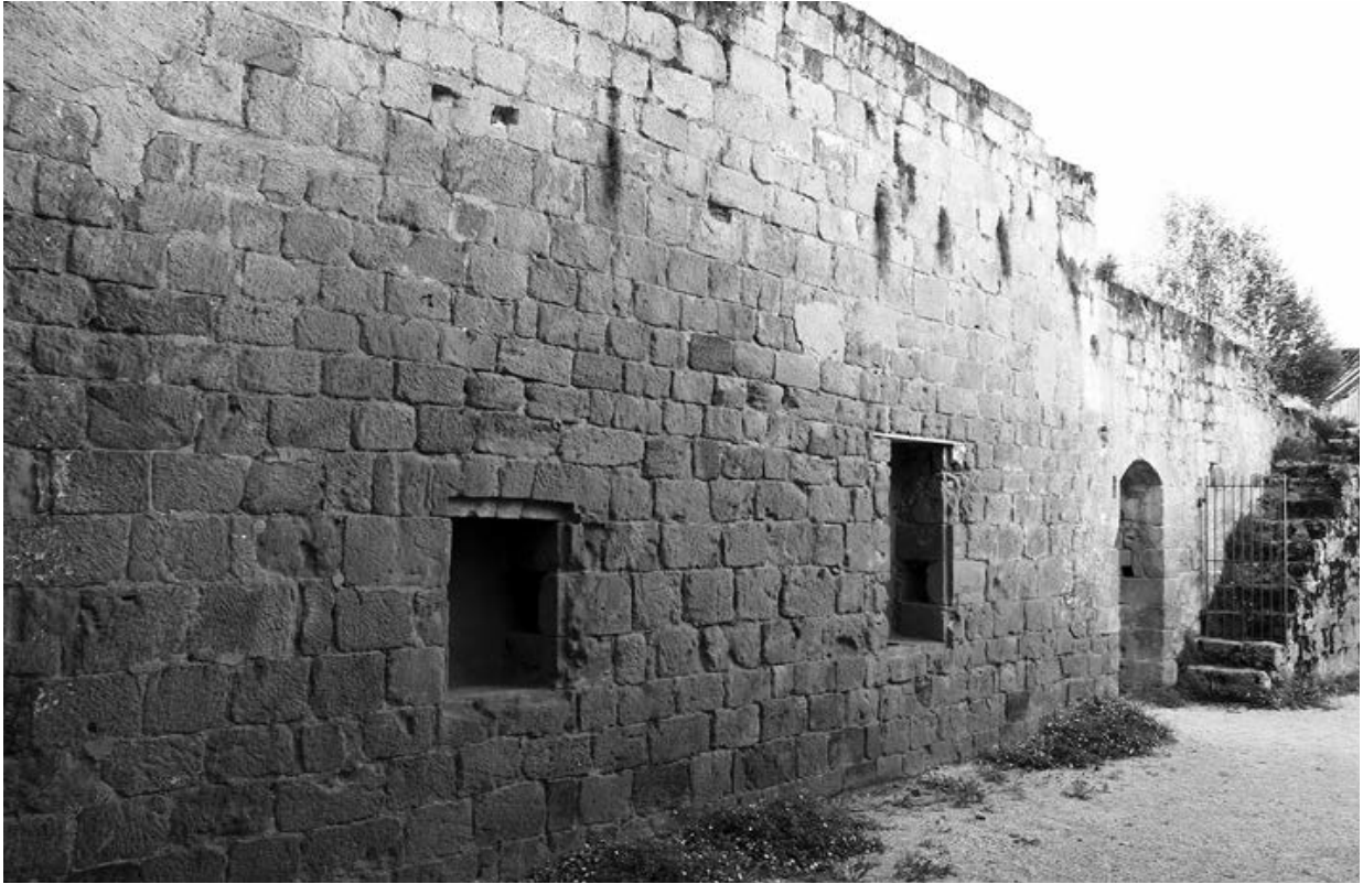
Fig. 3 – Marciac, vue intérieure du mur ouest, depuis l'entrée au sud. Remarquer les niches rectangulaires et la porte, qui marque la limite du premier état du bâtiment.
