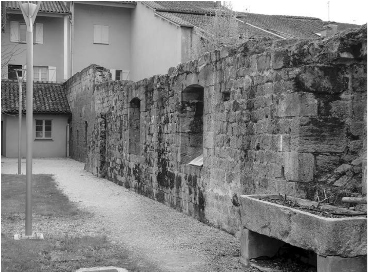
Fig. 4 – Marciac, vue intérieure du mur ouest, photographie depuis le nord. Remarquer la différence de teinte entre le mur du premier plan, percé d'étroites fenêtres à large ébrasement intérieur, et le mur au fond, plus clair et doté de niches rectangulaires. Une porte (remontée) marque la limite entre ces deux états.
