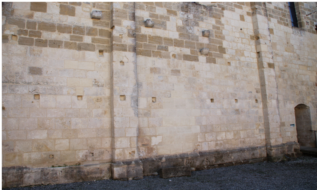
Doc. 4. Vue du mur gouttereau nord de la nef, côté cloître. On remarque une série de percements destinés à accueillir les solives des deux étages disparus du cloître, mais aussi des percements plus bas qui supportaient sarcophages et plaques funéraires. Photo S.A. 2017.
