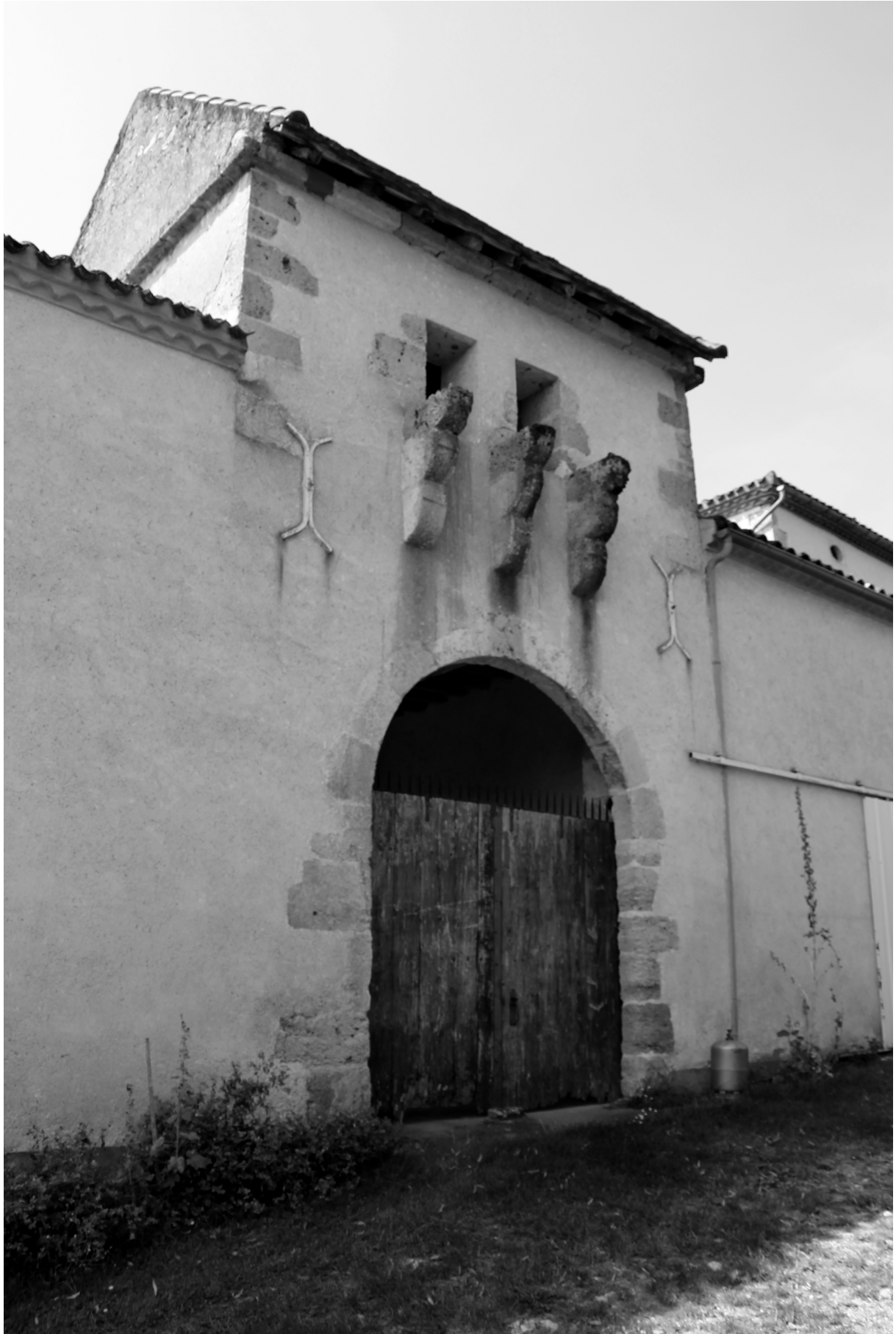
Fig. 6. La grangerie de Sainte-Marthe à Vianne. Portail d'entrée. Photo S.A.
