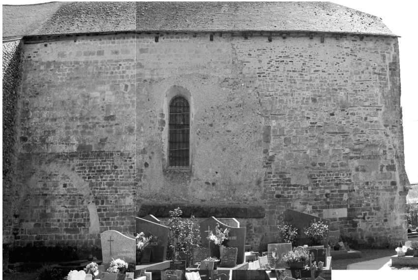
Fig. 8. Vue du mur nord de l'église. Photographie S.A.
