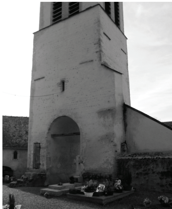
Fig. 15. Ancienne tour-porte transformée en clocher et départ de muraille. Photo S.A.
