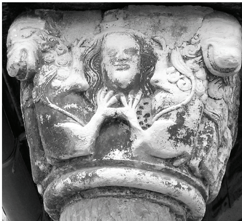
Fig. 3. Chapiteau de la façade ouest : tête de roi entre deux fauves. Photographie S.A.
