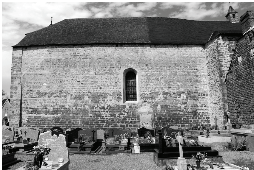
Fig. 5. Vue de la façade sud de l'église. Photographie S.A.
