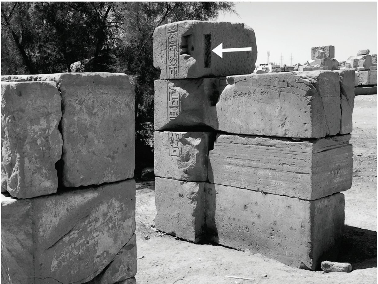
Fig. 22. Montant gauche, embrasure intérieure, détail de l'encastrement pour une plaque recevant la gâche originelle. © Cnrs-Cfeetk/J.-Fr. Gout.
