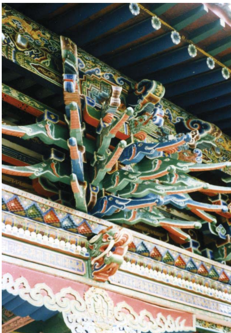
85. Jungyar juu (Ordos, état en 1995). Entablement tibétain soutenant des blocs de console sculptés en forme de têtes d'éléphants, sanctuaire.
