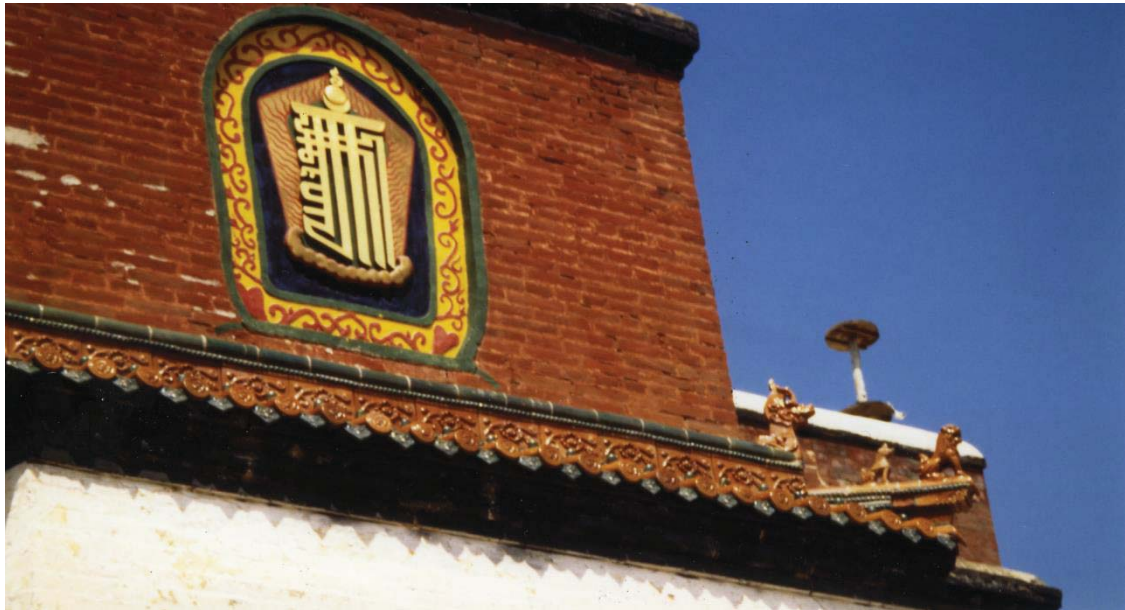
46. Cayan diyanci-yin keid (Josutu, état en 1996). Décor de façade avec le symbole du Kâlacakra. Briques et tuiles remplacent souvent la pierre et les décors de branchages tibétains.
