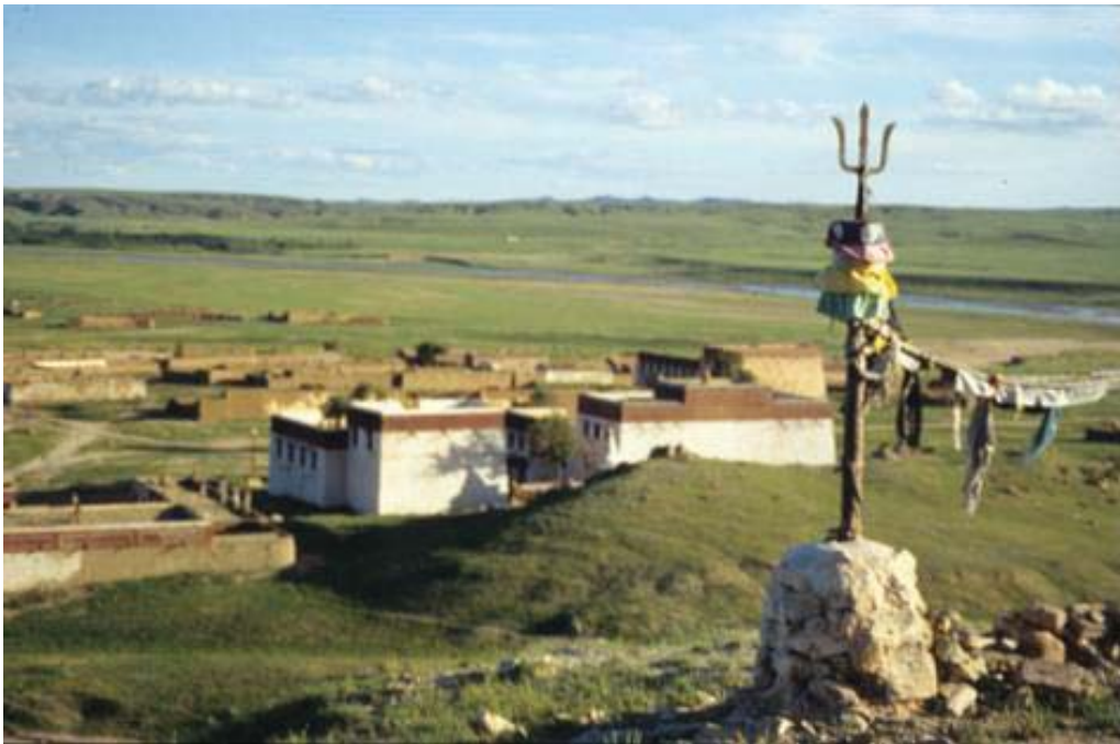
52. Sira mören sūme (Ulayancab, état en 1995). Adossé à la colline et orienté vers la rivière, le monastère bénéficie d'une géomancie idéale.
