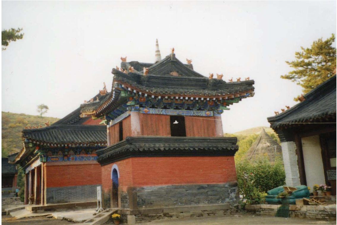
66. Fuhui si (Josutu, état en 2002). Tour de la cloche, restaurée en 2002.
