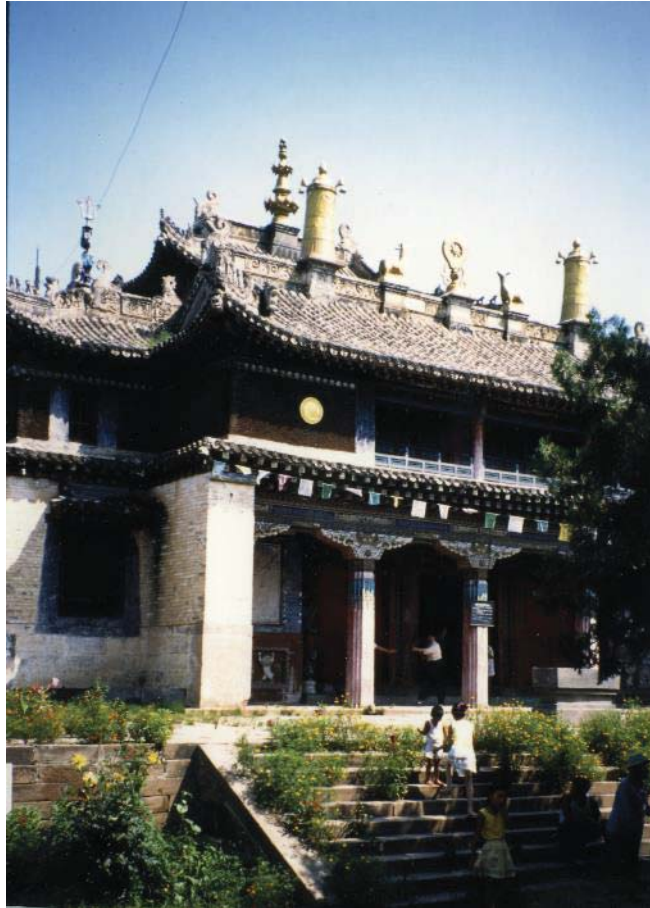
22. Huining si (Josutu, état en 1996 avant son déménagement en raison de la création d'un barrage et d'un lac de retenue). Façade de la salle d'assemblée d'époque Qing, 1738, reconstruite en 1876.
