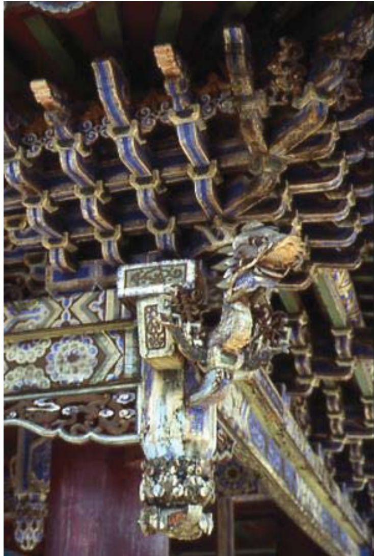
84. Yeke juu (Kökeqota, état en 1993). Pilier, architrave et dougong du porche du youl coçyin .
