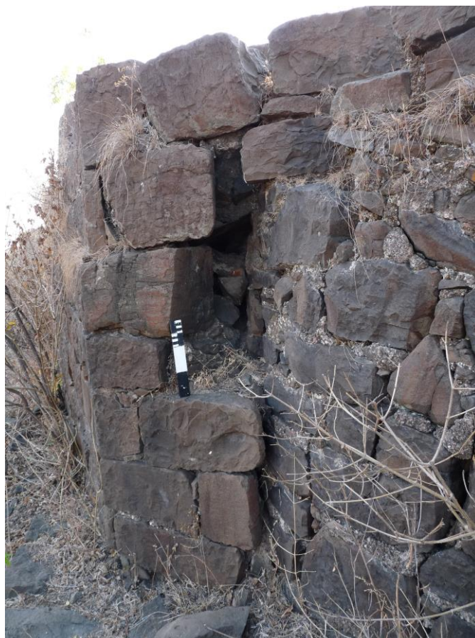
Figure 92 : rehaussement de l'enceinte des tours 33 à 39
