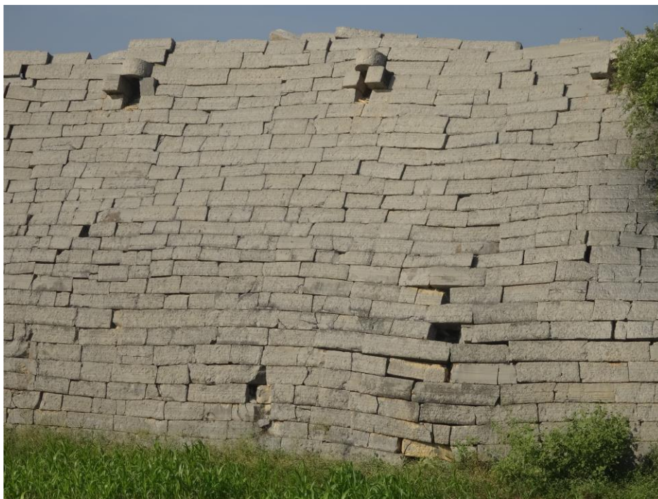
Figure 83 : bretèche capuchon de Firozâbâd, 1399
