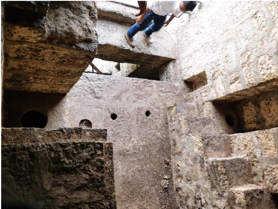
Figure 19 : arrivée d'eau à l'intérieur du barrage
