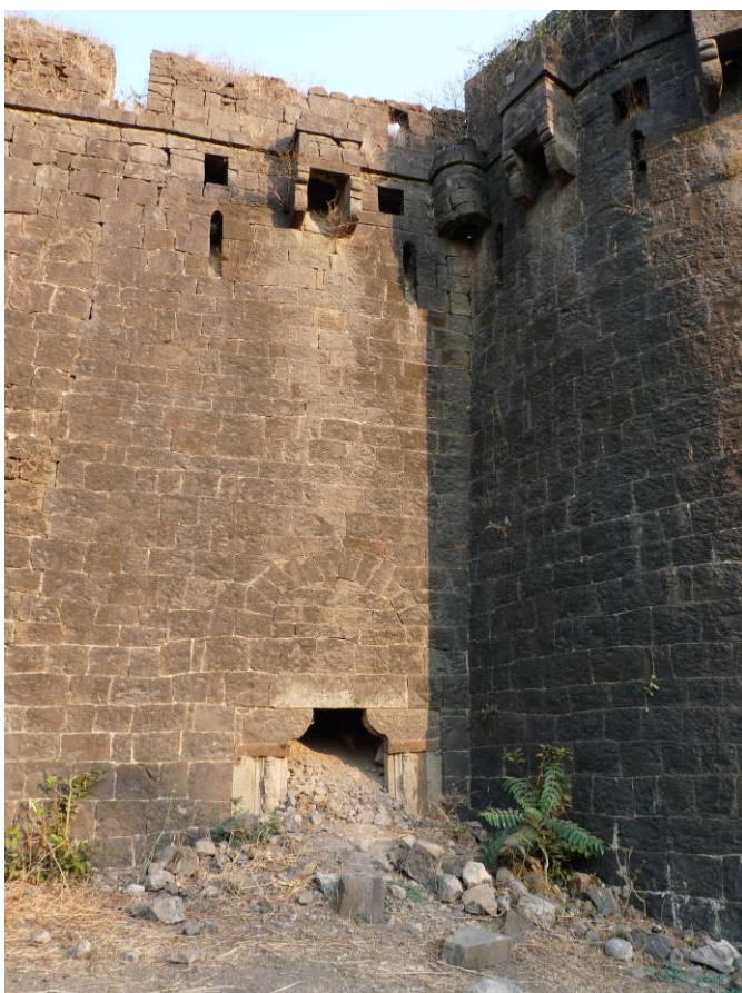
Figure 65 : poterne 5 surmontée d'une bretèche
