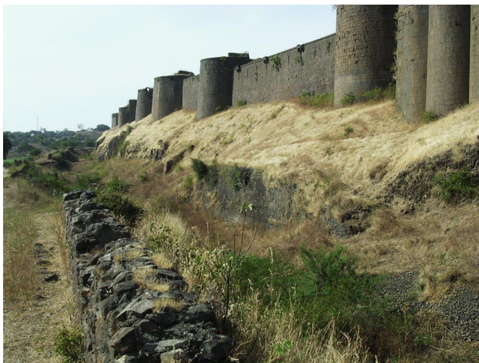
Figure 89 : front sud et le fossé
