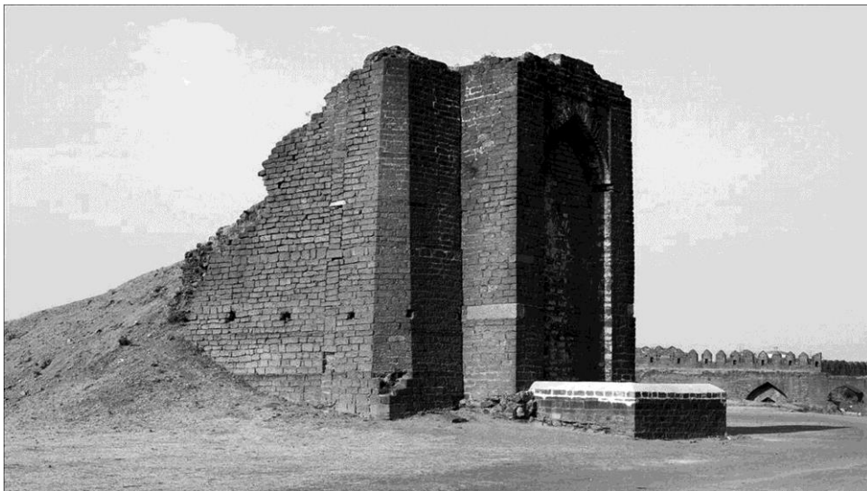
Figure 32 : tour à eau de Bidar (Kanataka)
