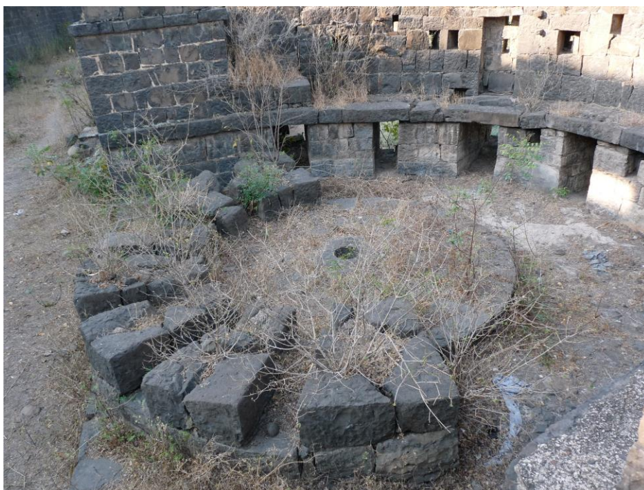
Figure 75 : plate-forme semi-circulaire pour canon dans la fausse braie
