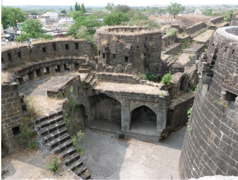
Figure 47 : vue de la barbacane de l'entrée P1
