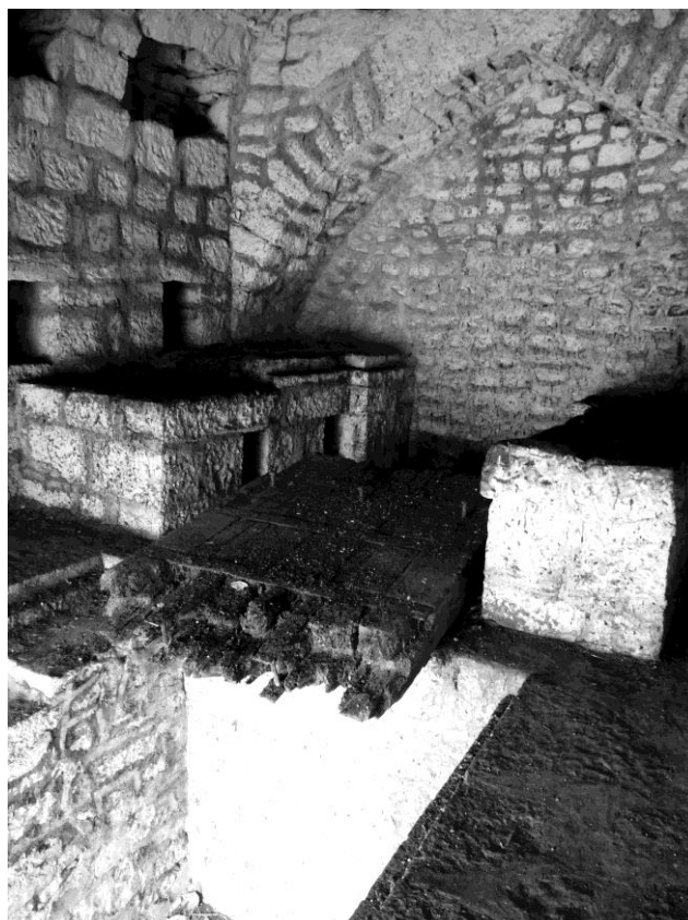
Figure 18 : chambre d'arrivée d'eau à l'intérieur du barrage
