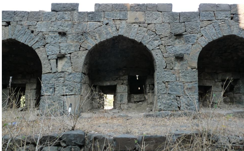
Figure 80 : casemates stéréotypées dans la fausse braie, enceinte basse
