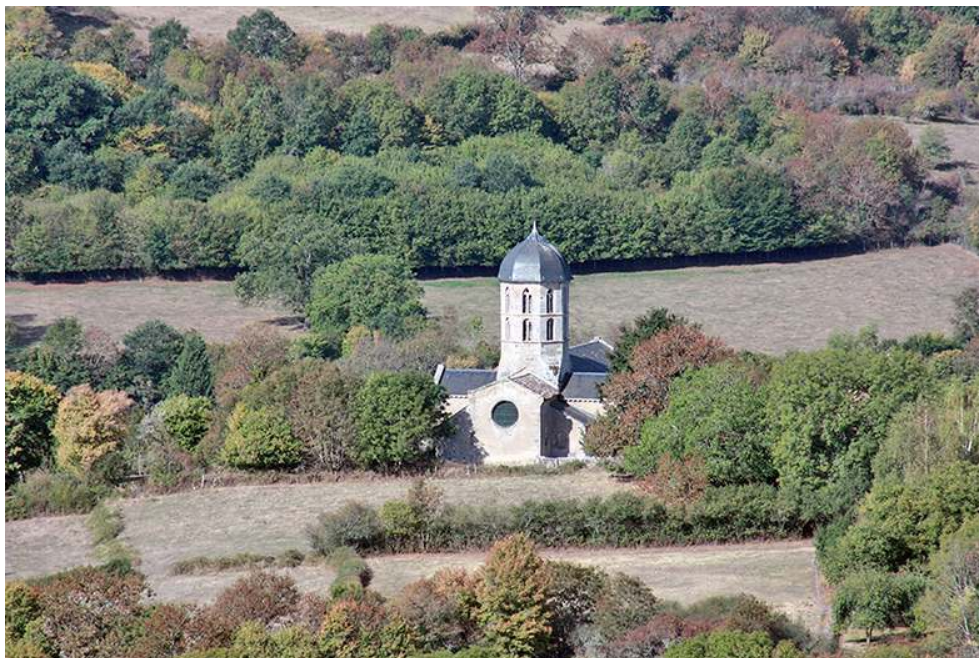
Fig. 2 – Vue sur l'église depuis la Montagne de Bard
