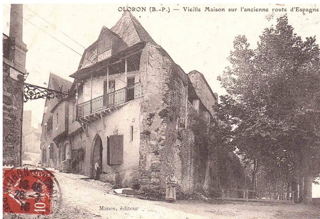
Fig. 20 : Vestiges du rempart antique d' Illuro , sectionnés par la rue Dalmais. Des maisons médiévales y ont été adossées (carte postale ancienne).
