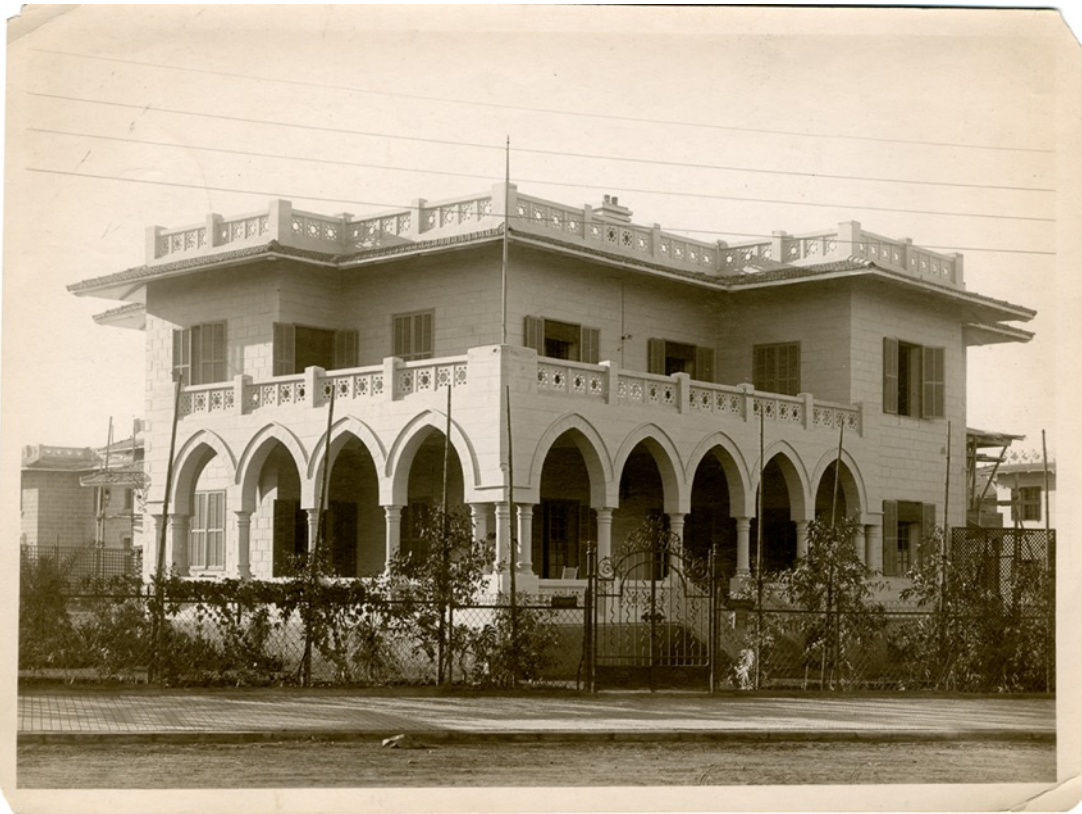
Fig. 5) Villa Type P, 1910-1912, Camille Robida, architecte (© Collection particulière)
