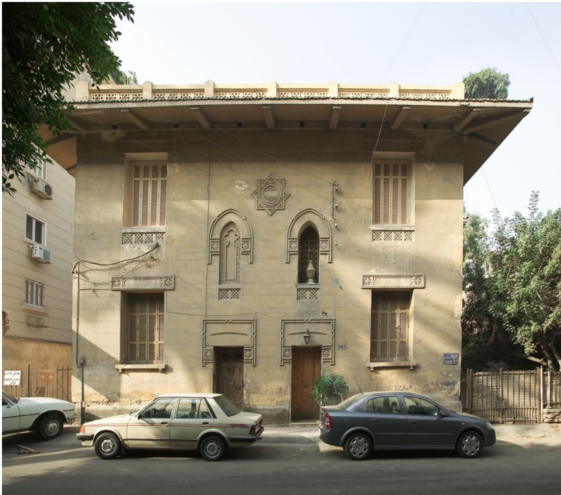
Fig. 6) Villa à appartements Type T1, 1910, Camille Robida, architecte (© Jean-François Gout/IFAO, 2004)
