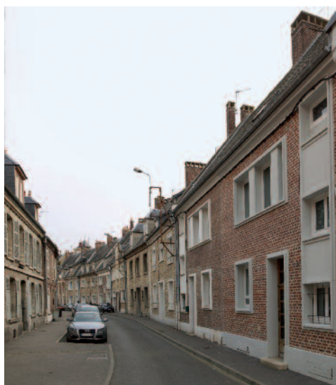
Fig. 29 Rue Alfred-François, à droite côté pair, les maisons reconstruites de l'îlot Gréber AU | cliché Marie-Laure Monnehay-Vulliet ©Région Hauts-de-France-Inventaire général ©Ville d'Abbeville.
