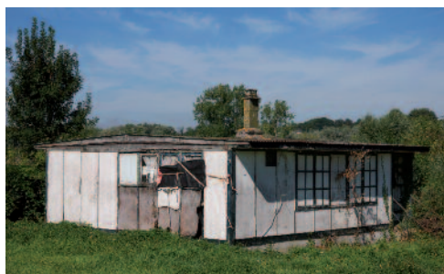
Fig. 18 Maison préfabriquée américaine sise 21 rue de l'Ermitage | cliché Marie-Laure Monnehay-Vulliet ©Région Hauts-de-France-Inventaire général ©Ville d'Abbeville.
