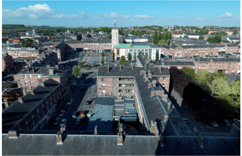
Fig. 59 Depuis l'église paroissiale Saint-Vulfran, îlots Tambuté de la rue du Pont-aux-Brouettes et de la place Max-Lejeune | cliché Marie-Laure Monnehay-Vulliet ©Région Hauts-de-France-Inventaire général ©Ville d'Abbeville.
