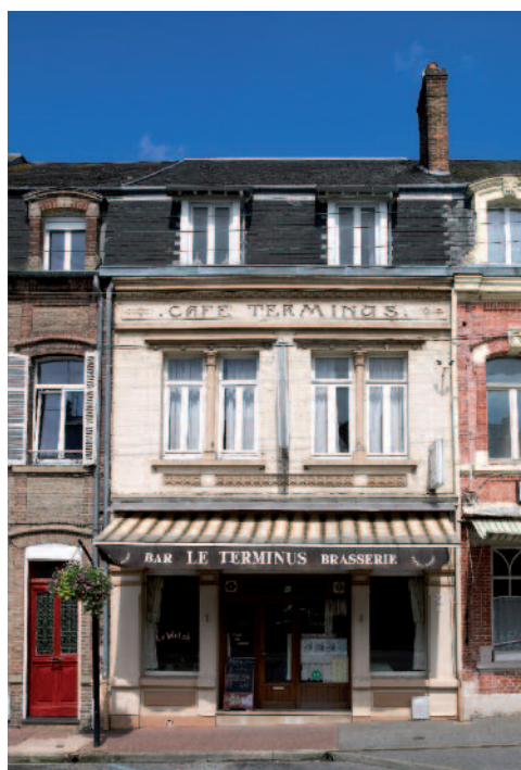
Fig. 3 Maison reconstruite après la Grande Guerre et abritant le café Terminus (4 avenue de la Gare), façade sur rue | cliché Marie-Laure Monnehay-Vulliet ©Région Hauts-de-France Inventaire général ©Ville d'Abbeville.
