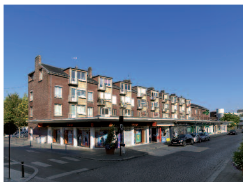
Fig. 39 Îlot Tambuté PF5, façades donnant rue Jean-de-Ponthieu | cliché Thierry Lefébure ©Région Hauts-de-France-Inventaire général ©Ville d'Abbeville.
