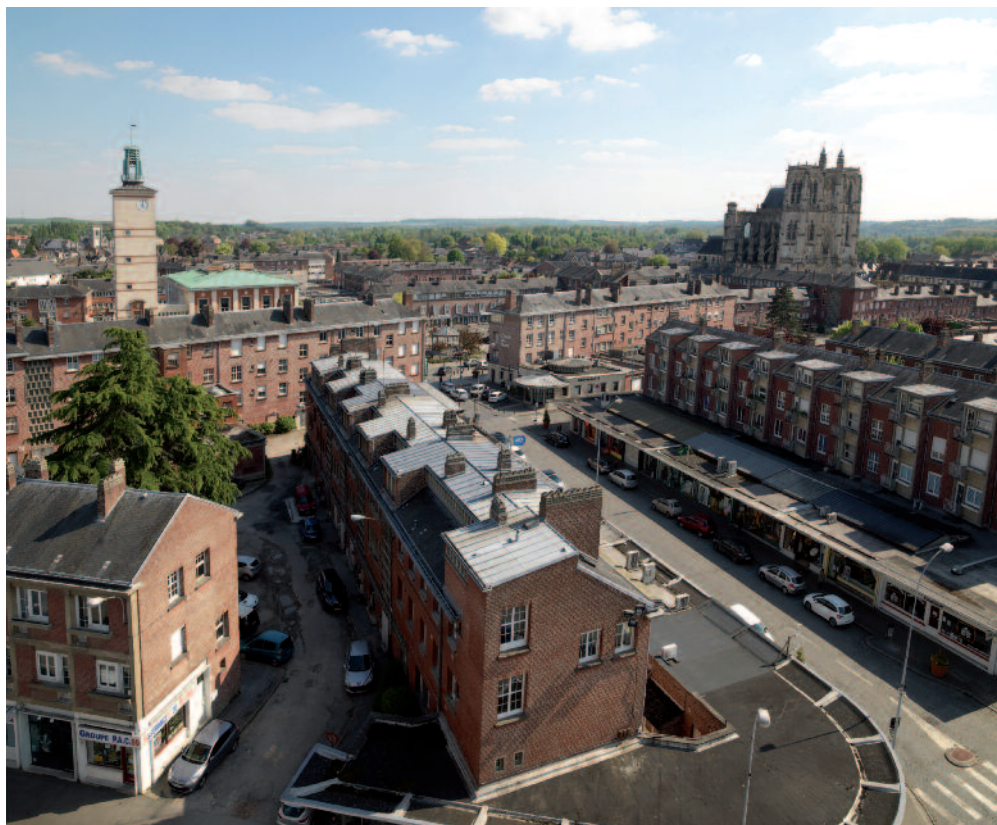
Fig. 1 Le centre reconstruit depuis le beffroi, à l'arrière-plan à gauche le beffroi du nouvel hôtel de ville, à droite l'église paroissiale Saint-Vulfran | cliché Marie-Laure Monnehay-Vulliet ©Région Hauts-de-France-Inventaire général ©Ville d'Abbeville.
