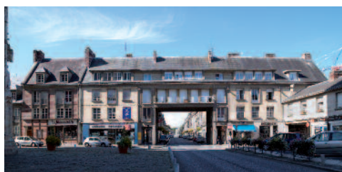
Fig. 44 Depuis le parvis Saint-Vulfran, immeuble-pont Tambuté reliant les îlots Gréber R et AF | cliché Marie-Laure Monnehay-Vulliet ©Région Hauts-de-France-Inventaire général ©Ville d'Abbeville.
