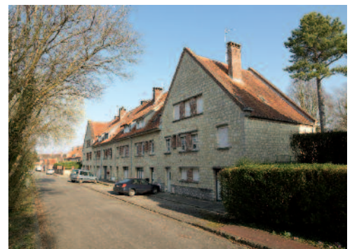
Fig. 34 Cité Leday, façade nord de l'unité A16 | cliché Marie-Laure Monnehay-Vulliet ©Région Hauts-de-France-Inventaire général ©Ville d'Abbeville.
