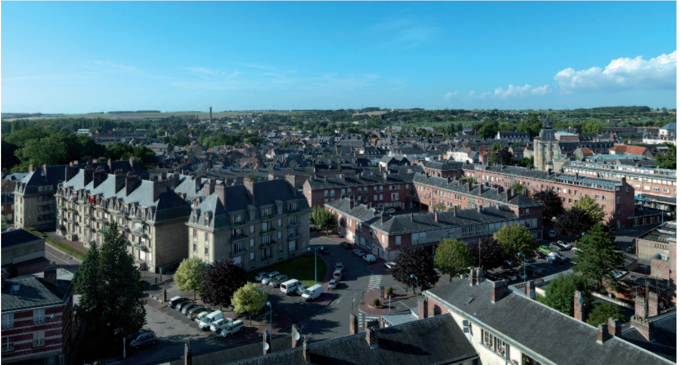
Fig. 57 Depuis l'église paroissiale Saint-Vulfran, à gauche les ISAI dits Le Guindal et à droite le Moulin-du-Roy – îlots Tambuté AL, PF5, PF9 et PF13 | cliché Marie-Laure Monnehay-Vulliet ©Région Hauts-de-France-Inventaire général ©Ville d'Abbeville.
