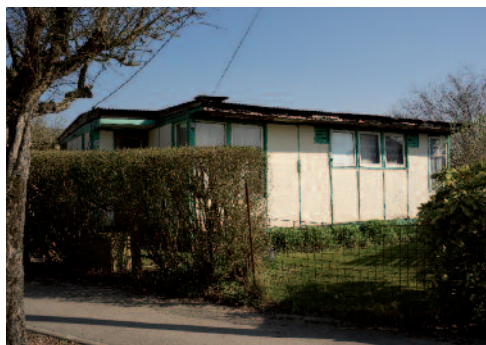
Fig. 17 Maison préfabriquée américaine sise 96 rue de la Chapelle | cliché Marie-Laure Monnehay-Vulliet ©Région Hauts-de-France-Inventaire général ©Ville d'Abbeville.
