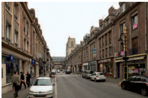
Fig. 43 Rue Saint-Vulfran bordée par des immeubles des îlots Gréber AF et R, lesquels sont reliés par un immeuble-pont Tambuté | cliché Marie-Laure Monnehay-Vulliet ©Région Hauts-de-France-Inventaire général ©Ville d'Abbeville.
