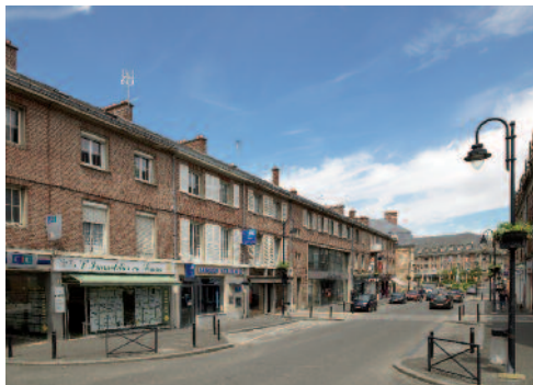
Fig. 48 Îlot Tambuté AO, immeubles alignés sur la rue des Lingers | cliché Marie-Laure Monnehay-Vulliet ©Région Hauts-de-France-Inventaire général ©Ville d'Abbeville.
