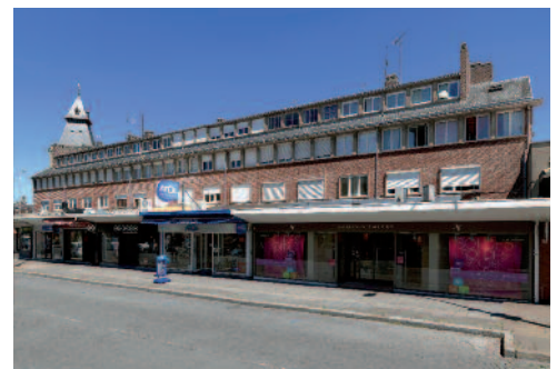
Fig. 42 Îlot Tambuté PF2, immeubles donnant sur la rue Jean-de-Ponthieu | cliché Thierry Lefebure ©Région Hauts-de-France-Inventaire général ©Ville d'Abbeville.
