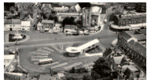
Fig. 25 Au premier plan, la gare routière, au second, le musée reconstruit autour du beffroi ruiné, carte postale, Cim éditeur, vers 1960 | Arch. mun. Abbeville, fonds de cartes postales ©Ville d'Abbeville.
