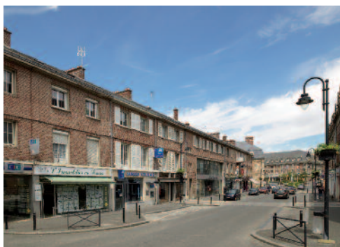
Fig. 48 Îlot Tambuté AO, immeubles alignés sur la rue des Lingers | cliché Marie-Laure Monnehay-Vulliet ©Région Hauts-de-France-Inventaire général ©Ville d'Abbeville.
