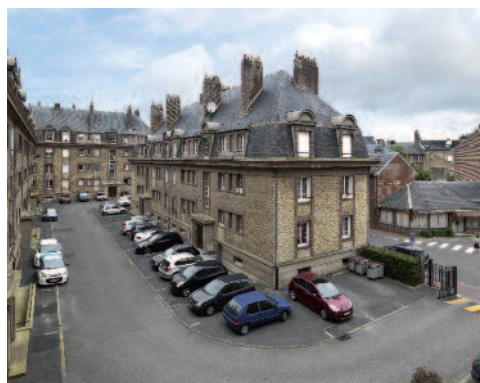
Fig. 36 ISAI, dits Le Guindal, bâtiment nord-est depuis le bâtiment sud-est | cliché Thierry Lefebure ©Région Hauts-de-France-Inventaire général ©Ville d'Abbeville.
