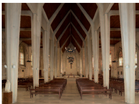
Fig. 55 Église paroissiale Saint-Gilles, vaisseau central depuis le portail | cliché Marie-Laure Monnehay-Vulliet ©Région Hauts-de-France-Inventaire général ©Ville d'Abbeville.
