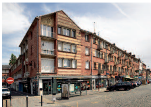
Fig. 50 Îlot Tambuté PF10, immeuble situé à l'angle de la rue du Maréchal-Foch et de la place de la Libération | cliché Marie-Laure Monnehay-Vulliet ©Région Hauts-de-France Inventaire général ©Ville d'Abbeville.
