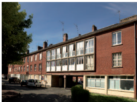
Fig. 45 Ensemble dit du Moulin-du-Roy, îlot Tambuté PF9, immeuble situé à l'est et incluant un passage | cliché Marie-Laure Monnehay-Vulliet ©Région Hauts-de-France-Inventaire général ©Ville d'Abbeville.
