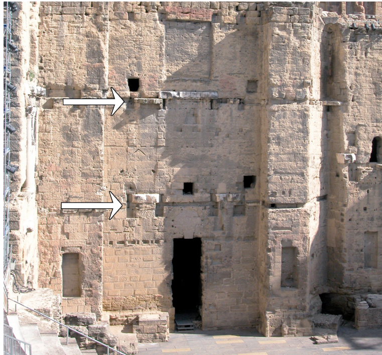
Fig. 202 - La zone latérale occidentale du mur de scène (cliché J.-Ch. Moretti, relevés et dessins M.-G. Froidevaux, A. Badie et M. Cabarrou)
