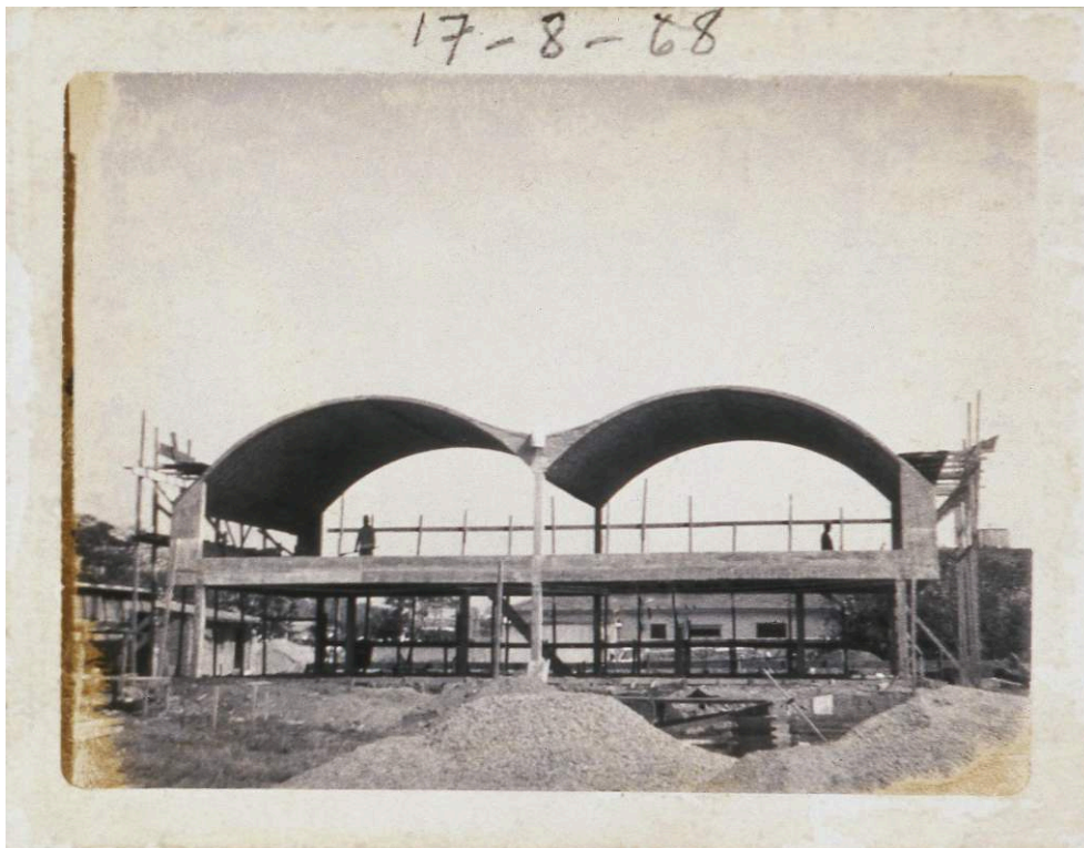
Figure 10 : Maison Juarez Brandão Lopes (1968), chantier et vue de la rue vers 1970.
