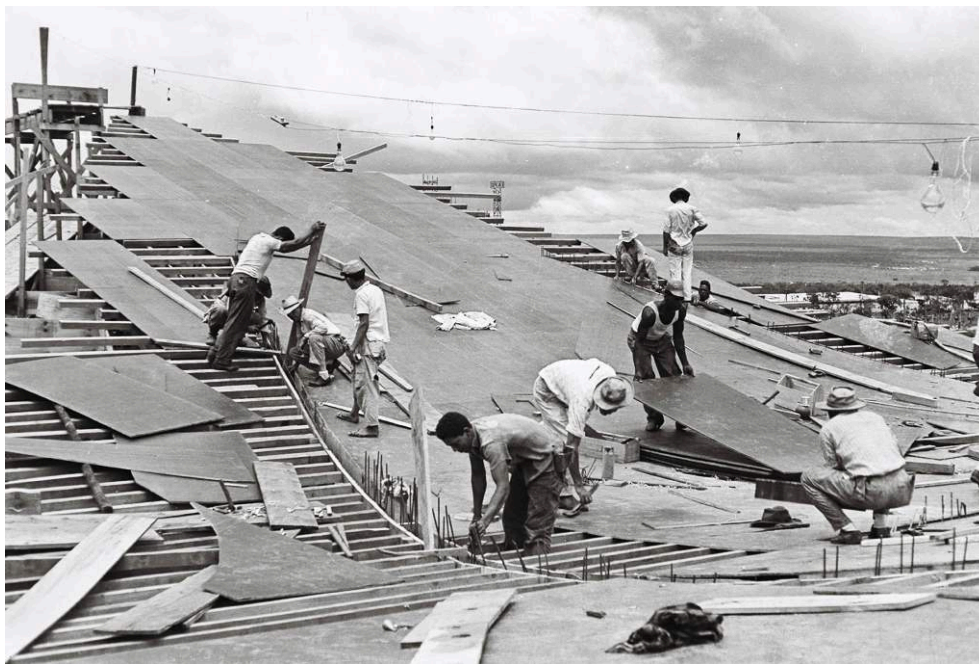
Figure 4 : Ouvriers candangos sur les chantiers de Brasília en construction
