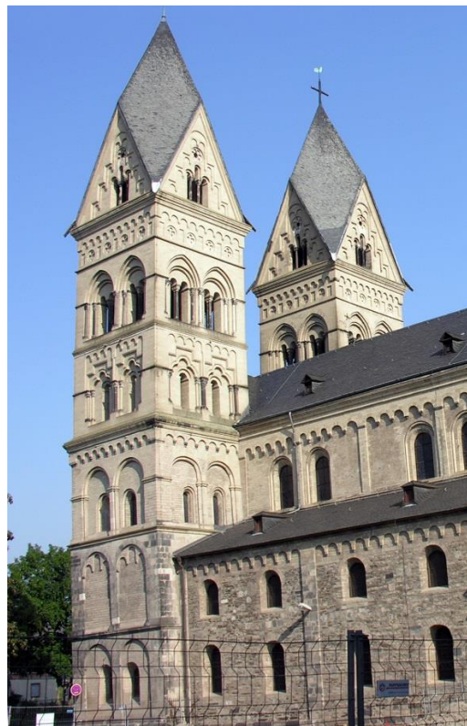
Fig. 112. Andernach. Église Ste-Marie. Deux tours ouest (début XIII e s.). Détail d'une photo en ligne Ph. Jakkés et Wikimedia Commons.
