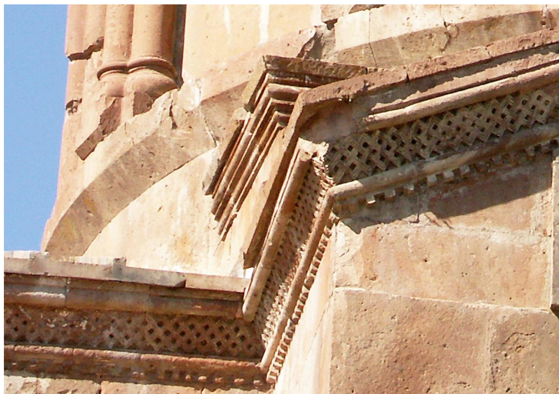
Fig. 44. Marmašēn, église principale. Détail de la corniche du haut des façades.
