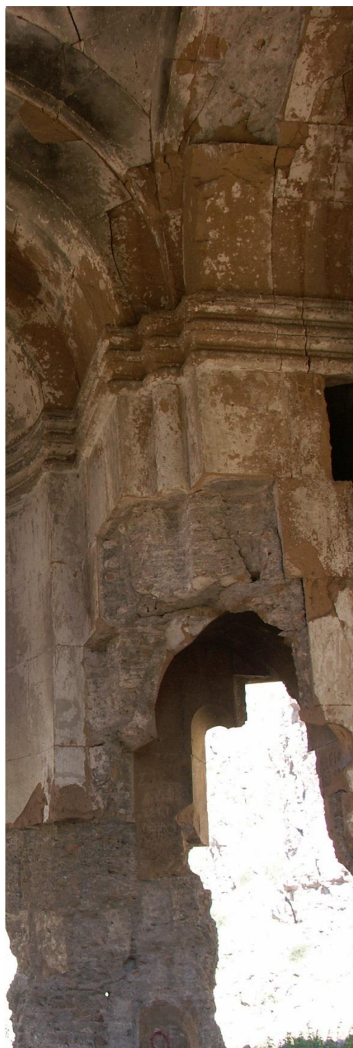
Fig. 120. Xckōnk'. St-Serge. Angle intérieur nord-est. Comparaison des photos de 1980 et de 2013 : une pierre en forme de demi-colonne est tombée.
