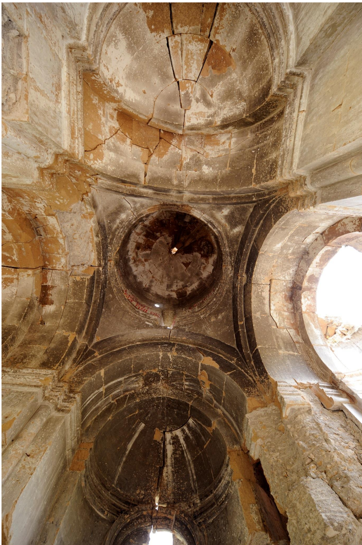
Fig. 127. Xckōnk' . St-Serge. Vue zénithale de l'intérieur. Photo Hraïr Hawk Khatcherian, 2008.
