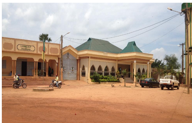
Image 1: Façade avant du Lamidat de Ngaoundéré
