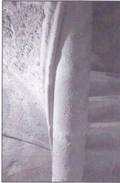
Le noyau et la voûte de l'escalier en vis disposé au sud de la nef (cliché Mathias Dupuis / Conseil départemental des Alpes-de-Haute-Provence, Service départemental d'archéologie)
