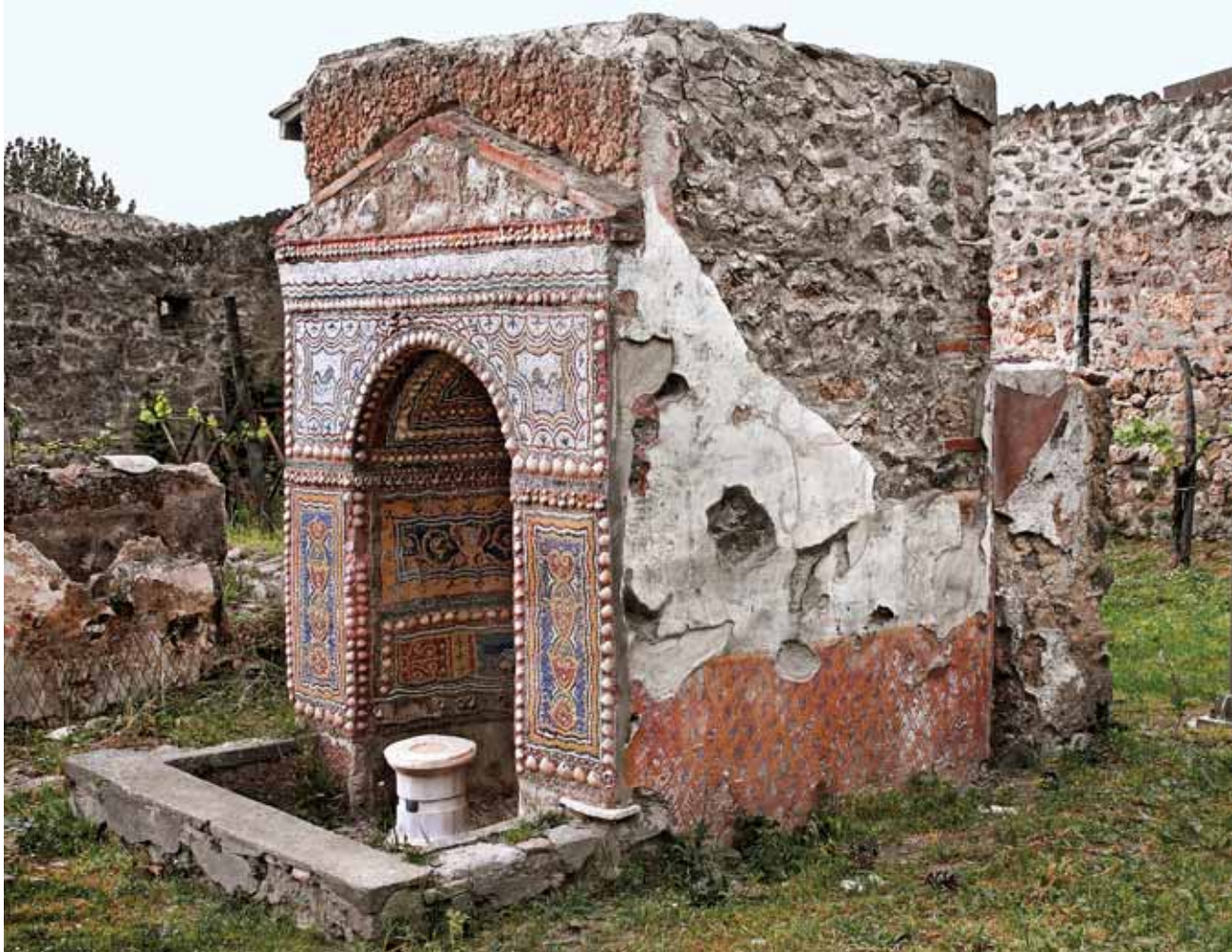
Fig. 56 – Pompéi, II 9, 6 : fontaine-édicule nord (vue depuis l'est).
