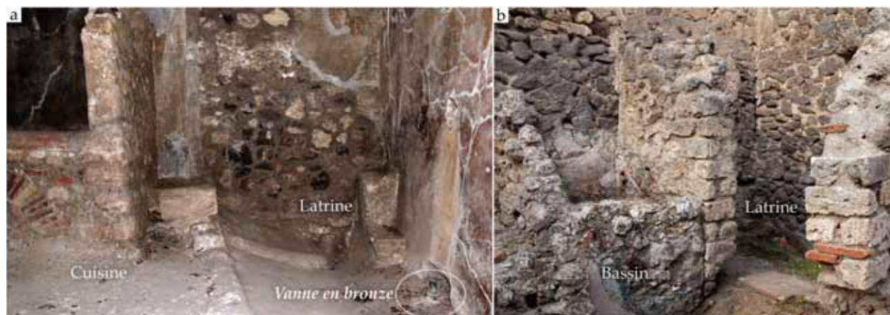
Fig. 140 – Pompéi, latrines et cuisines. a. Casa di Fabius Rufus (VII Ins. Occ., 16-22) (vue de l'ouest); b : Casa di L. Caecilius Jucundus (V 1, 10), avec bassin adjacent (vue du sud-ouest).
