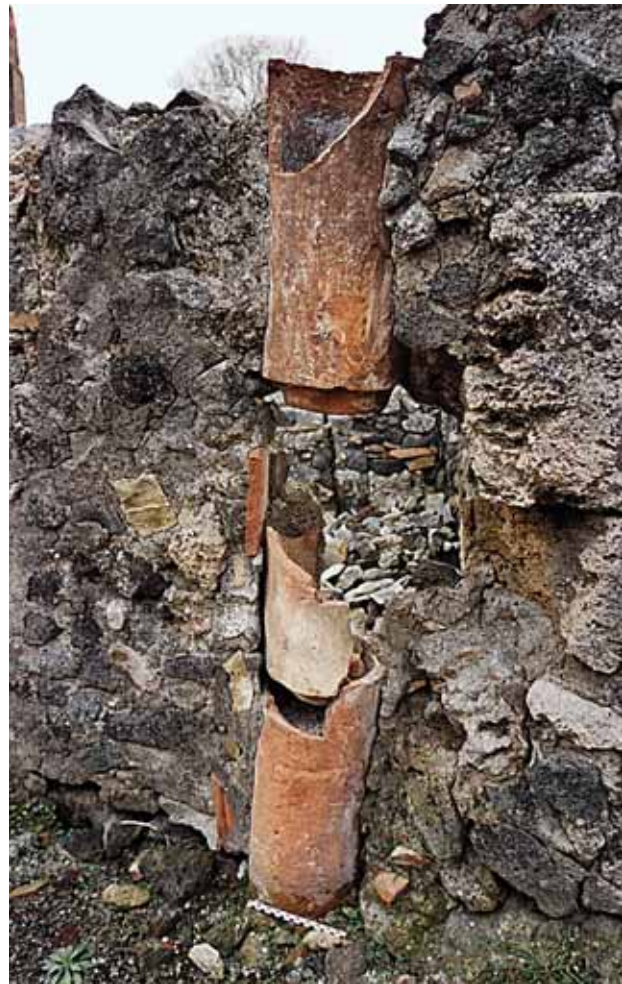
Fig. 97 – Pompéi, VI 1 : conduites de terre cuite acheminant les eaux usées de l'étage.
