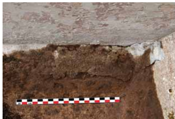
Fig. 20 – Pompéi, Casa di L. Aelius Magnus (VIII 2, 14-16) : bouchage avec coulée de plomb d'une fuite au fond du bassin (angle nord-est).
