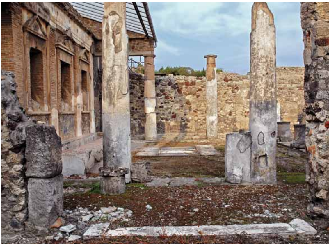
Fig. 60 – Pompéi, Casa del Torello (V 1, 7-9) : bases à jets d'eau sur le côté ouest du portique.
