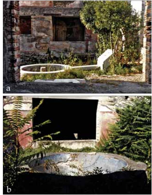
Fig. 179 – Pompéi, vues latérales sur des bassins circulaires. a : Casa di M. Lucretius Stabia (IX 3, 5/24) (vue du sud); b : Casa di Fabius Rufus (VII Ins.Occ., 16-22) (vue du sud).
