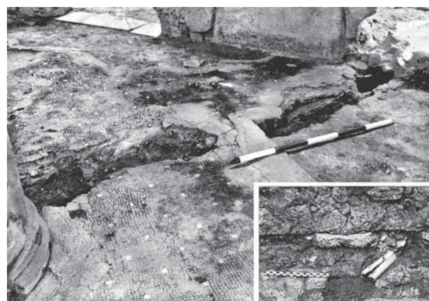
Fig. 119 – Pompéi, Casa delle Vestali (VI 1, 7/25), péristyle nord, portique est : saignée correspondant à la conduite de plomb, en direction du jardin; détail du reste de conduite à l'entrée du jardin (vue de l'ouest).
