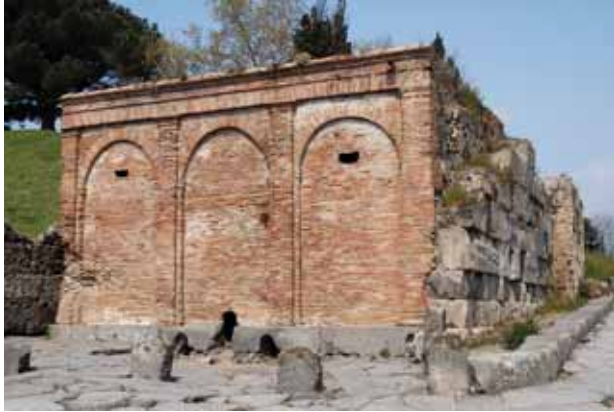
Fig. 109 – Pompéi, château d'eau principal de la Porta del Vesuvio (vue du sud).
