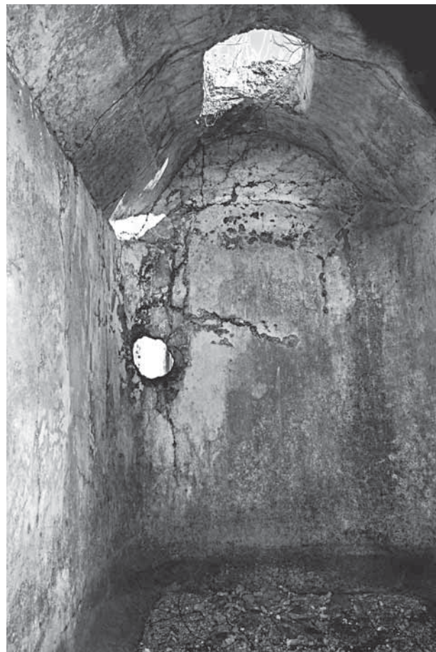
Fig. 107 – Pompéi, Praedia di Julia Felix (II 4) : intérieur du réservoir (vue de l'ouest).
