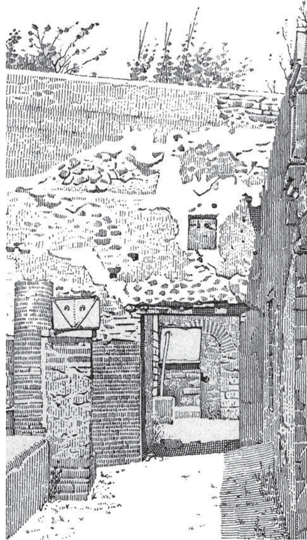
Fig. 135 – Boscoreale, villa de la Pisanella : perspective sur les réservoirs distributeurs en plomb (Pasqui 1897, fig. 45).
