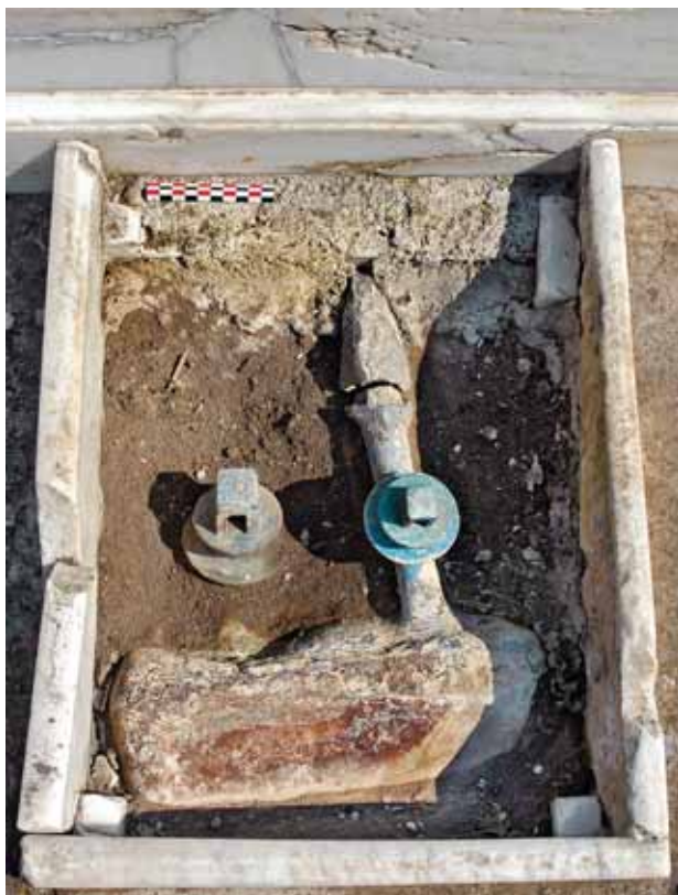
Fig. 105 – Pompéi, cylindre de plomb de Pompéi, avec conduites et robinets, alimentant les fontaines de l' impluuium de VI 14, 20; organisé dans un caisson en marbre, à l'ouest de l' impluuium .
