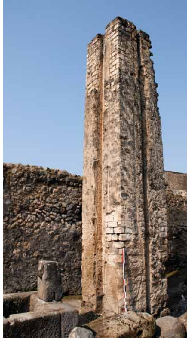
Fig. 110 – Pompéi, château d'eau secondaire n° 1 (VI 16).
