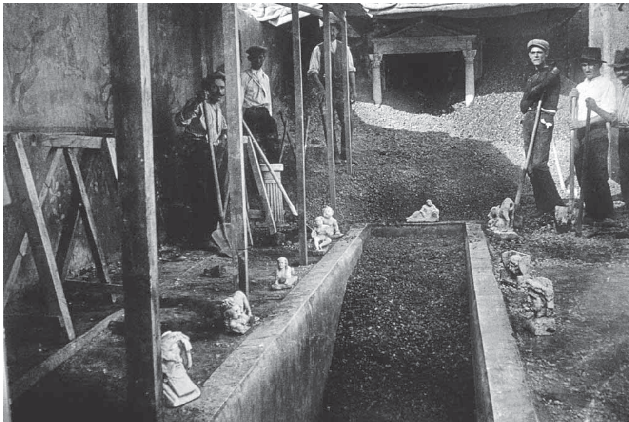
Fig. 65 – Pompéi, Casa di Octavius Quartio (II 2) : le bassin transversal avec sa mise en scène statuaire, en cours de fouilles, en 1920 (SAP, cliché B339) (vue de l'ouest).
