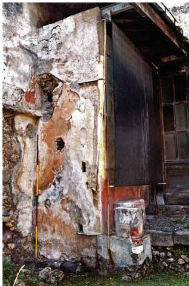
Fig. 129 – Pompéi, Casa dell'Efebo (I 7, 10-12) : le réservoir (vue depuis le sud).
