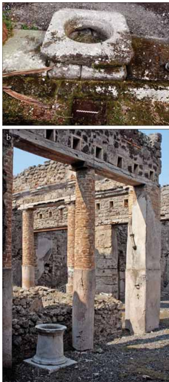
Fig. 87 – Pompéi, récupération des eaux de toiture des portiques. a : déversoir et canalisation devant le stylobate ouest de VI 11, 9; b : conduite de plomb récupérant les eaux pluviales à l'angle nord-est du péristyle de la VI 14, 21-22.
