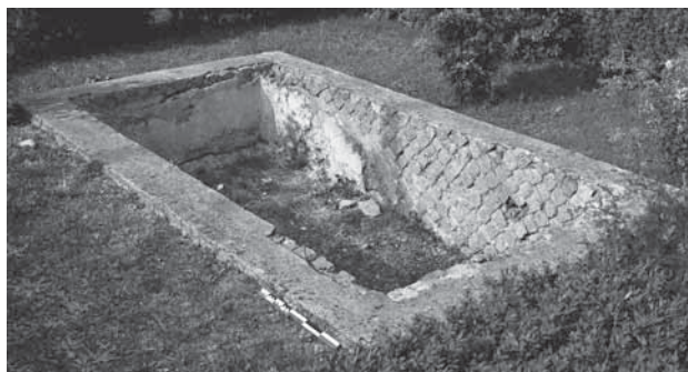
Fig. 15 – Pompéi, Casa di Tritolemo (VII 7, 5-14) : bassin en opus reticulatum (vue du sud-ouest).
