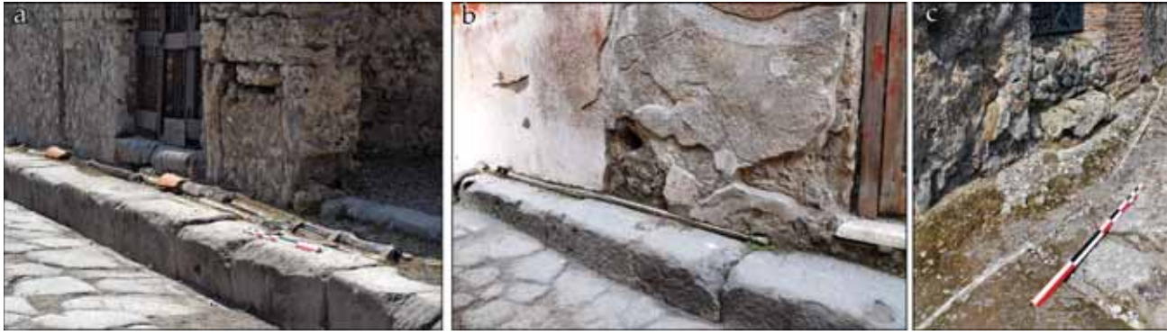
Fig. 100 – Pompéi, conduites de plomb sur les trottoirs. a : VI 13 (vue du nord-est); b : entrée de conduite dans la maison VII 12, 23 (vue du nord); c : VI 15, 5 (vue du sud).
