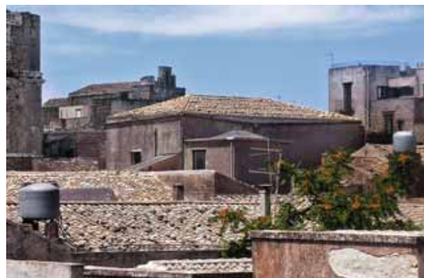
Fig. 136 – Erice, en Sicile : cuves – réservoirs sur les toits de la ville moderne.
