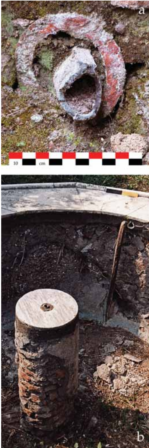
Fig. 21 – Pompéi. a : Casa dell'Efebo (I 7, 10-12/19) : alimentant le bassin du jardin, conduite de plomb protégée par une conduite de terre cuite; b : Casa di P. Paquius Proculus (I 7, 1) : alimentation de la colonne centrale par une conduite de plomb (visible sur la paroi nord) et évacuation du trop-plein avec une conduite en plomb adjacente.
