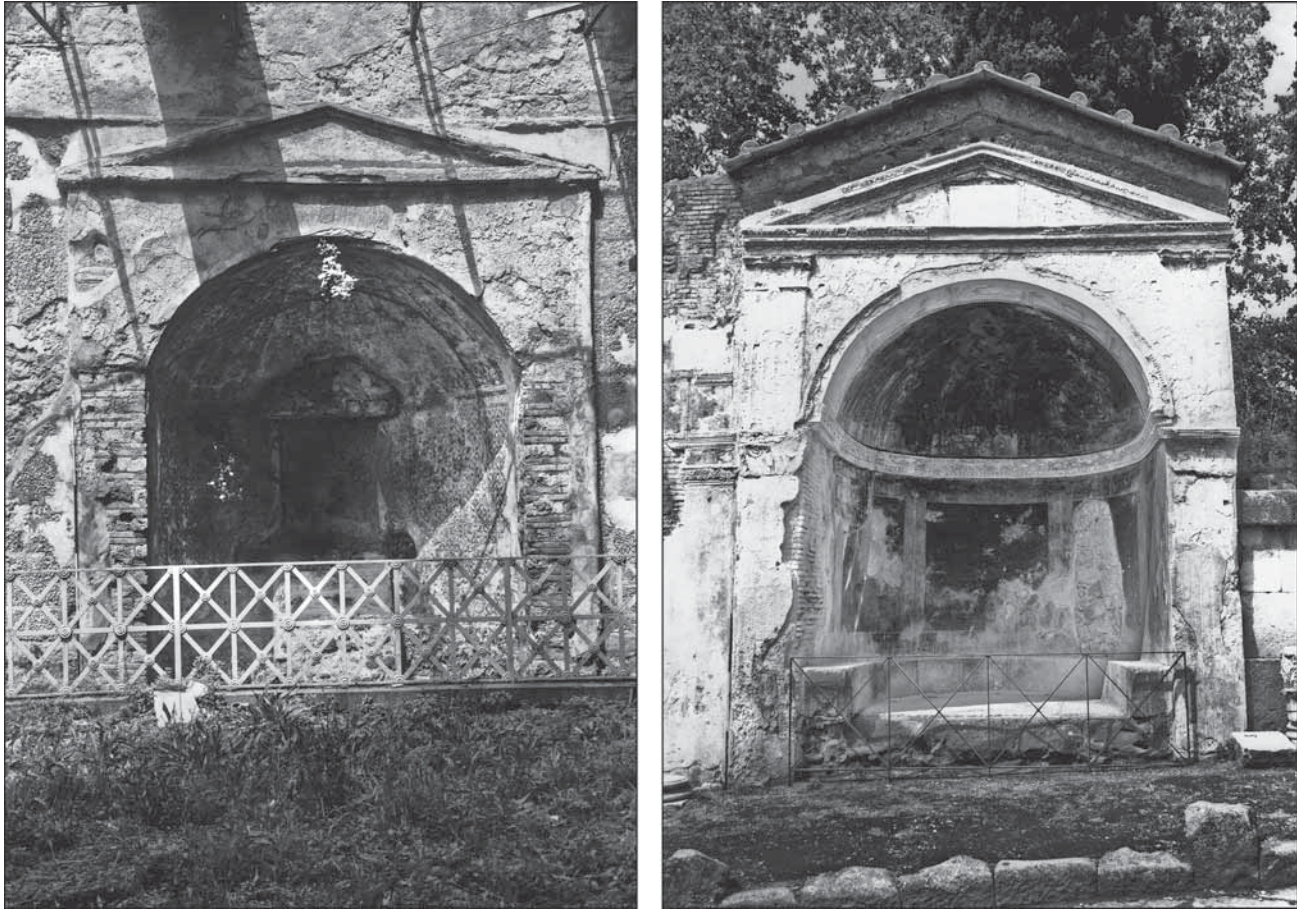
Fig. 52 – Pompéi, Via dei Sepolcri, édifices décorés de conques : fontaine de la Villa delle Colonne a Mosaico (n° 9); tombe adjacente (n° 11) (vue depuis l'ouest).
