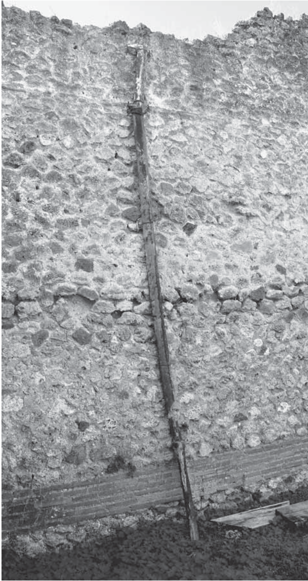
Fig. 134 – Pompéi, VII 12, 11 : conduite de plomb descendant le long du mur.
