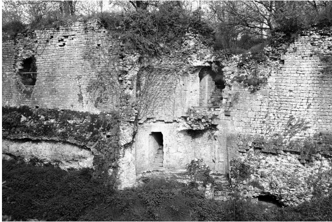
Fig. 3 - Guainville, Le Vieux Château, vue de la tour d'angle A (en 2008). L'effondrement ancien de la partie extérieure laisse voir la tour en coupe, avec sa poterne à l'angle avec la courtine.
