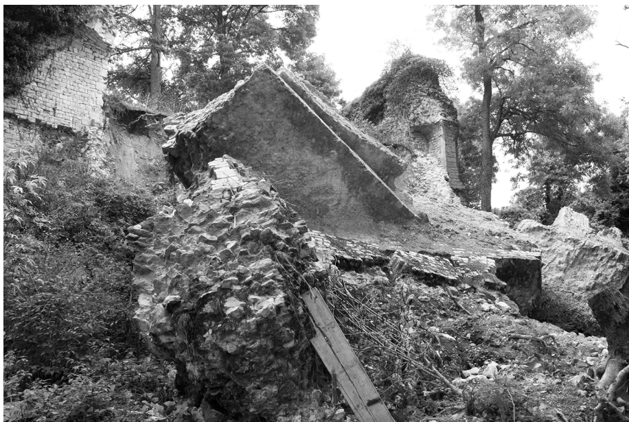
Fig. 6 - Guainville, Le Vieux Château, vue de la courtine C-D effondrée en 2016.
