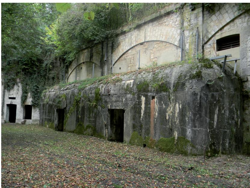
Figure 3 : renforcement casematé en béton ajouté sur la caserne du cavalier en 1895 du fort de Vancia.
