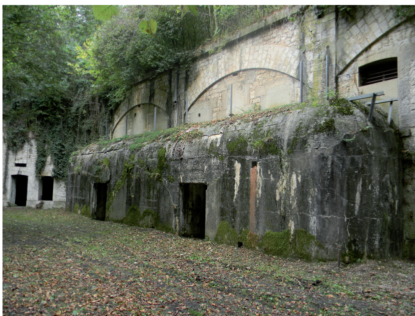
Figure 3 : renforcement casematé en béton ajouté sur la caserne du cavalier en 1895 du fort de Vancia.
