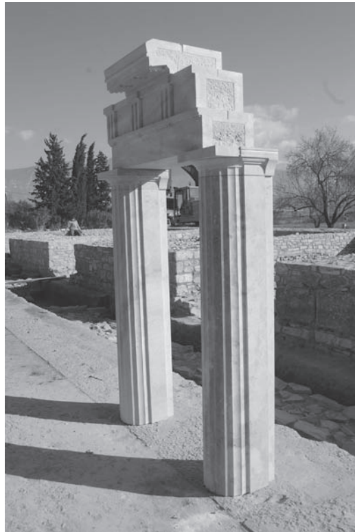
9. Restauration partielle du proskènon du théâtre de Démétrias.
