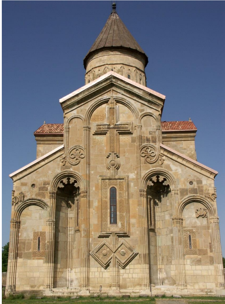
Fig. 28. Samtavisi (Géorgie – 1030). Façade E.
