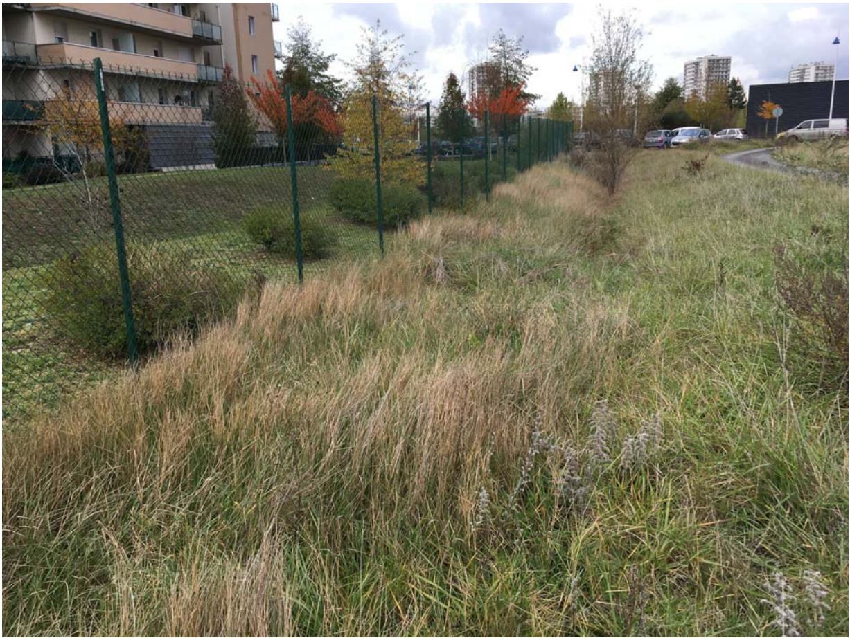
Figure 5. Des noues d'écoulement des eaux occupées par la végétation dans le quartier des Deux Lions à Tours
