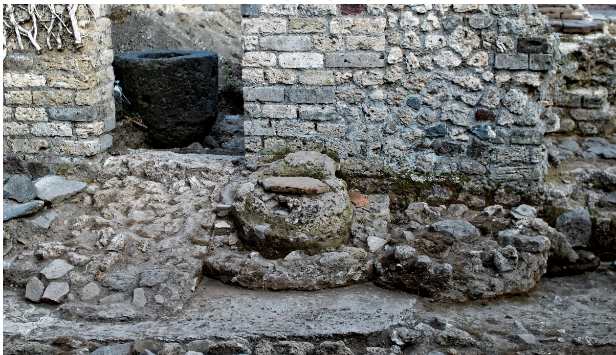
Fig. 9. Supports de jattes dans la boulangerie I 3, 27 à Pompéi. Sur la gauche, en arrière de la rampe, un pétrin mécanique en cours de démontage au moment de l'éruption (Cliché N.M. sur concession du Ministero dei beni e delle attività culturali e del turismo – Soprintendenza Pompei – reproduction interdite par quelque moyen que ce soit).
