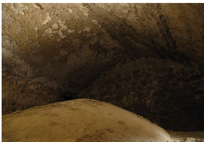
Fig. 15. Vue de l'intérieur de la coupole du four en VII 2, 3.6-7. Notez le premier rang de blocs en trachyte (cliché A. Coutelas).
