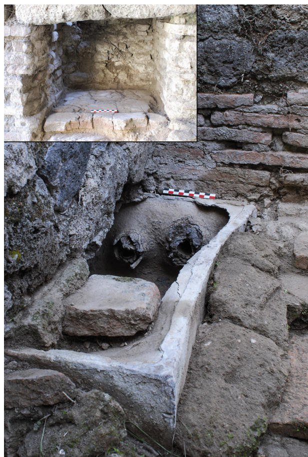
Fig. 13. Chauffe-eau en plomb inclus dans le four de la boulangerie VII 12, 11. La face supérieure ayant disparu, on voit les tuyaux de remplissage et de vidange dans la paroi. En encadré, chambre de chauffe du même aménagement, vu de l'autre côté (clichés N. Monteix).
