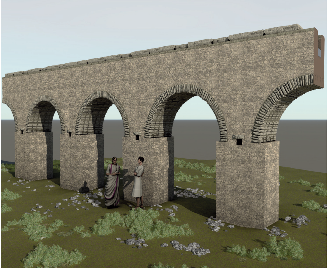
Fig. 6. Proposition de restitution 3D des "arches de Parigny" avec matérialisation des trous de boulins actuellement apparents (© É. Follain).
